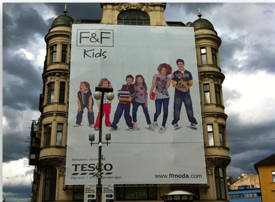
Obrázek 4 - Nevhodně umístěná reklama hyzdící historický dům na Jungmannově náměstí na Praze 1, jež musela být odstraněna dle nařízení vedení této městské části (zdroj: https://images.app.goo.gl/6CPp84Mqns3kyJe58 )
