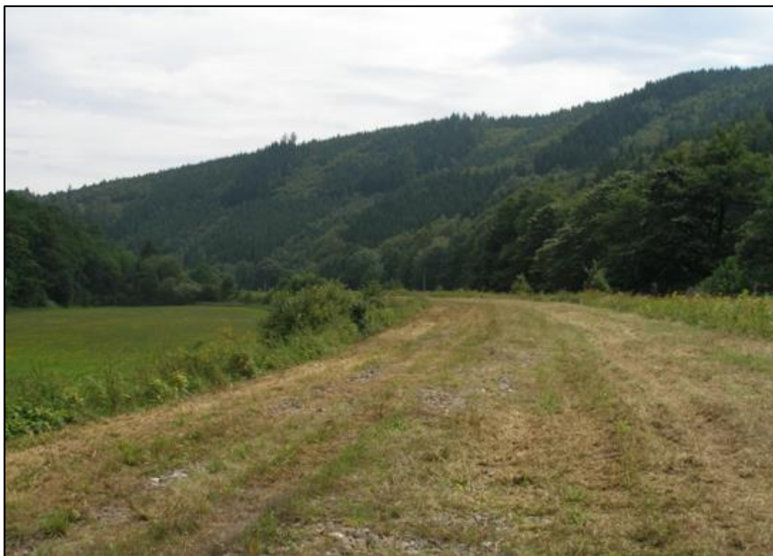
Obr. 10: Těleso zrušené tratě se sneseným železničním svrškem (stav 2010)
