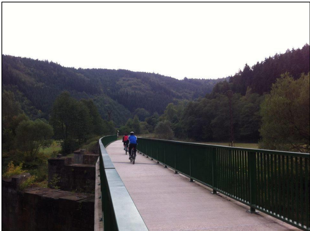
Obr. 4: Cyklisté na zrekonstruovaném mostě
