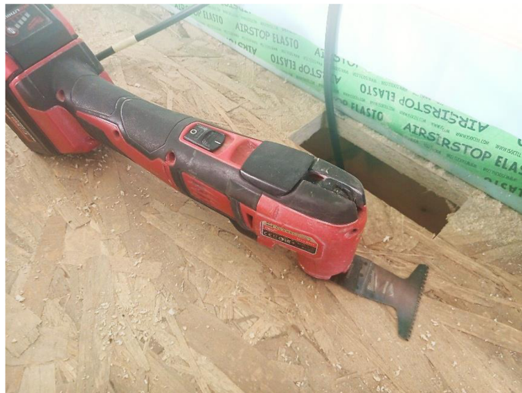
Obrázek 4 Oscilační pila s vyříznutým průstupem v podlaze
