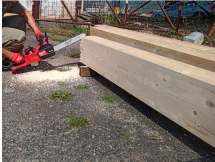
Obrázek 29 Hrubé krácení elektrickou řetězovou pilou
