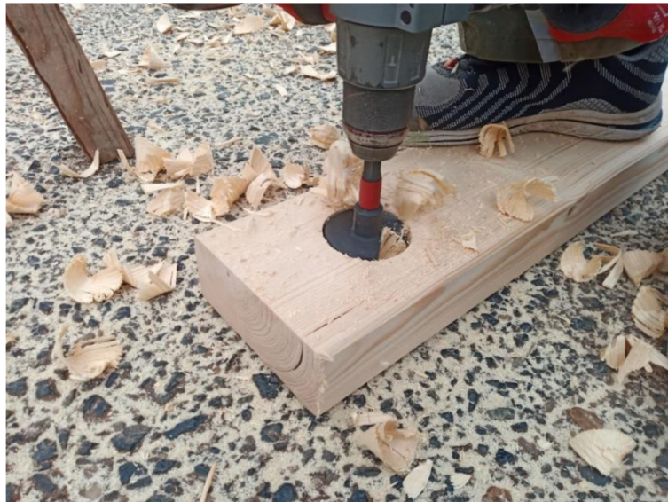
Obrázek 25 Vrtání otvoru v prahu Forstnerovým vrtákem
