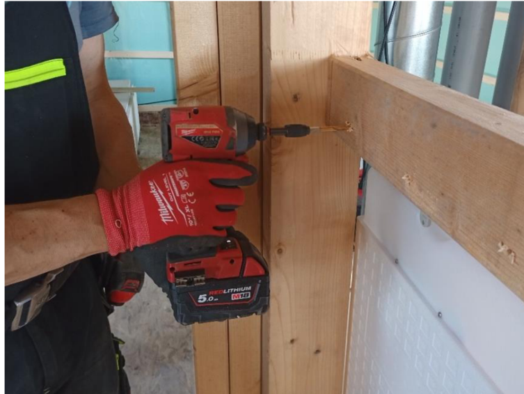
Obrázek 27 Rázový utahovák se šroubovitým vrtákem pro předvrtávání
