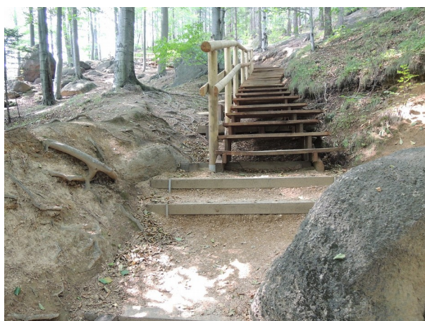
Obr. 55: Trasa je zde zpočátku velmi důkladně upravená Zdroj: autor, 2016
