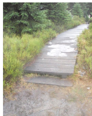
Obr. 7: Dřevěný chodník Zdroj: autor, 2015
