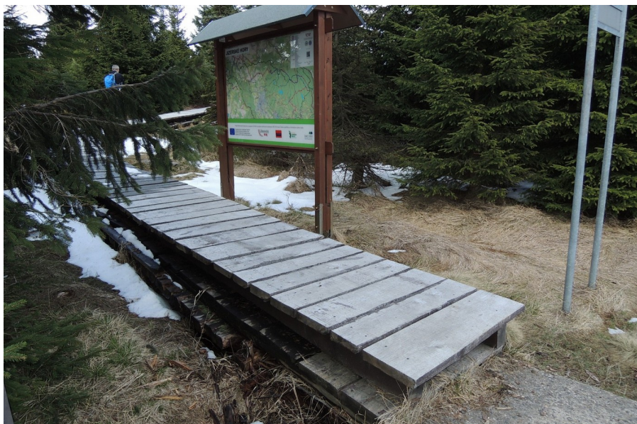
Obr. 31: Tři vrstvy dřevěných chodníků blízko rozcestí Holubník - sedlo Zdroj: autor, 2016
