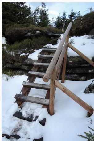
Obr. 38: Dřevěné schody Zdroj: autor, 2016
