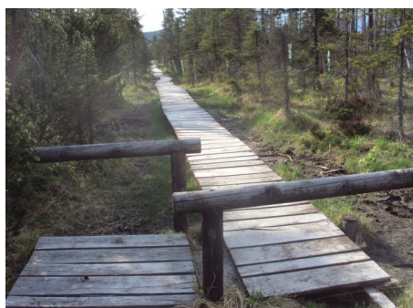
Obr. 12: Napojení dřevěných chodníků Zdroj: autor, 2015
