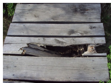
Obr. 9: Jedno z uhnílych prken Zdroj: autor, 2015
