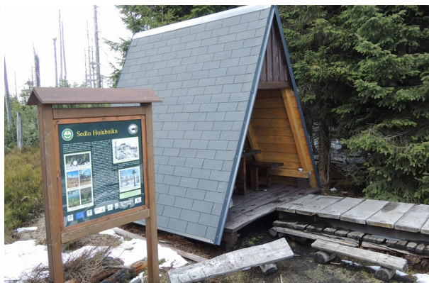
Obr. 32: Přístřešek v bezvadném stavu na rozcestí Holubník – sedlo Zdroj: autor, 2016
