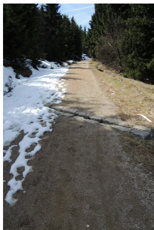
Obr. 18: Kamenný odvodňovací kanál Zdroj: autor, 2016
