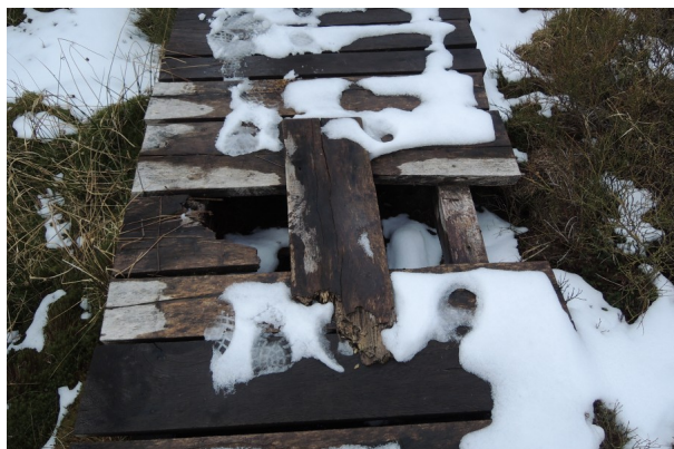
Obr. 28: Jedno ze dvou míst s uhnílým prknem Zdroj: autor, 2016
