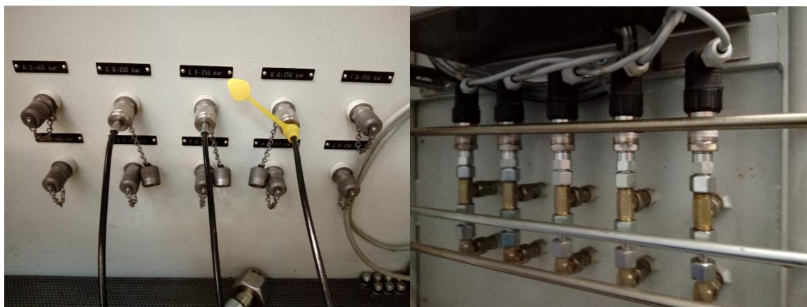
Obr. 15: Tlakové snímače a jejich připojení Minimes
