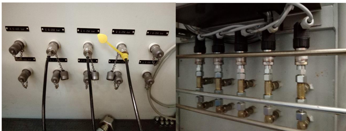
Obr. 15: Tlakové snímače a jejich připojení Minimes
