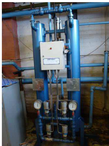
Obr. 4.14 Adsorpční sušička stlačeného vzduchu
