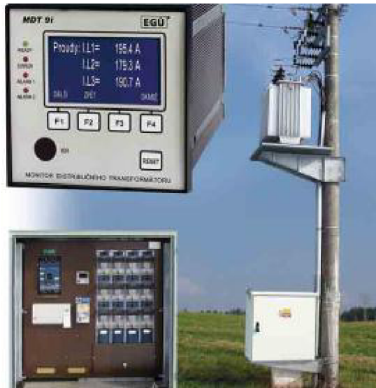
Obr. 5.5-1 Ukázka zapojení monitoru distribučního transformátoru[10]
