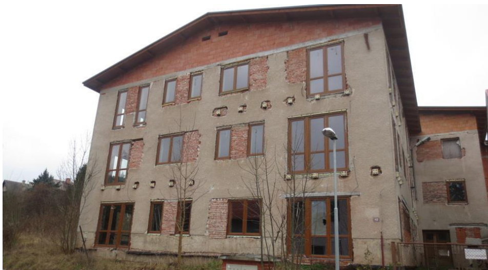
Obr. č. 11 Přestavba části bývalého Dřevotvaru na Kozinci
