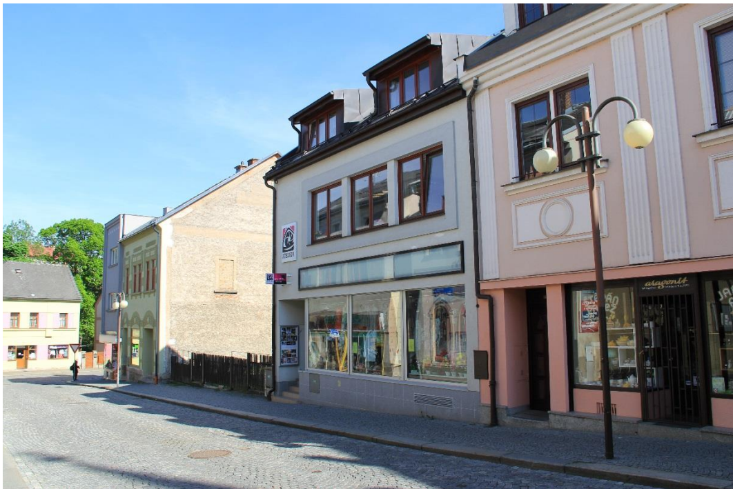
Na levém obrázku dům s č. p. 148, který zanikl v roce 1937. Napravo je pak detail podsíně domu č. p. 164. [25]
