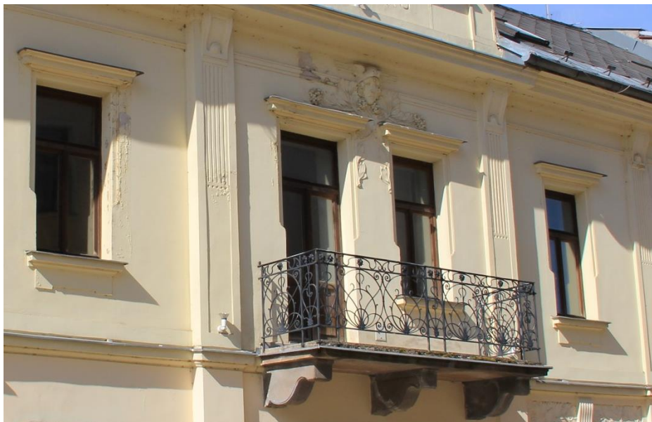
Obr. č. 37 Dům č. p. 94
