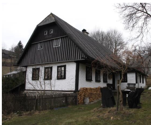
Obr. č. 21 Krčkové roubení na chalupě č. p. 3 v Horních Štěpanicích
