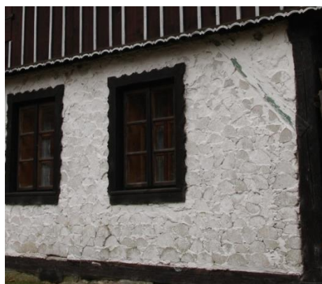
Obr. č. 21 Krčkové roubení na chalupě č. p. 3 v Horních Štěpanicích
