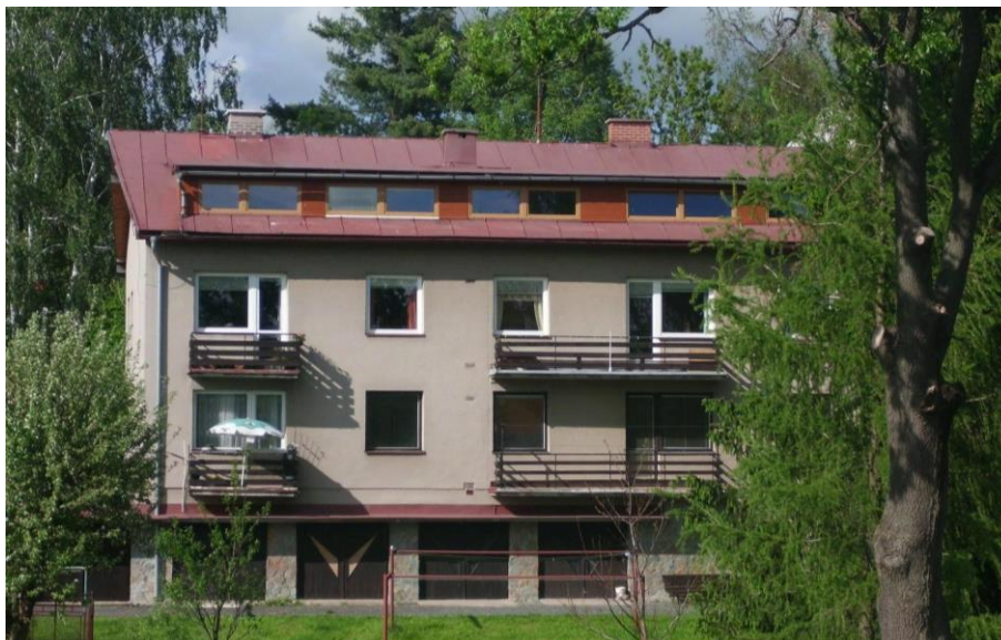
Obr. č. 44 Bytový dům u nemocnice
