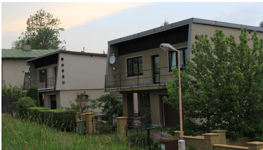
Obr. č. 41 Výstavba šumperáků na Nouzově
