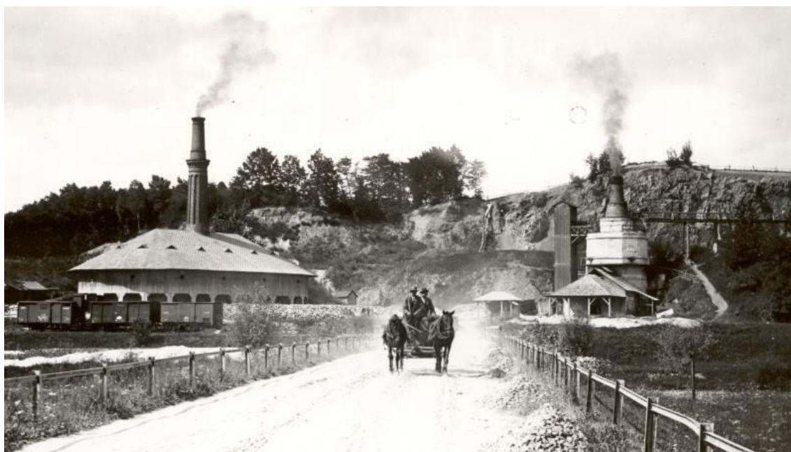
Obrázek 9 Pohled na vápenku, vlevo čtrnáctikomorová pec, nedatováno, zdroj: muzeum.mineral.cz
