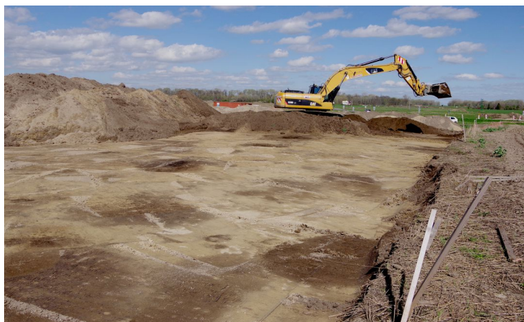
Obr. 5: Priebeh skrývky ornice mechanizmom s plochou svahovacou lyžicou.
