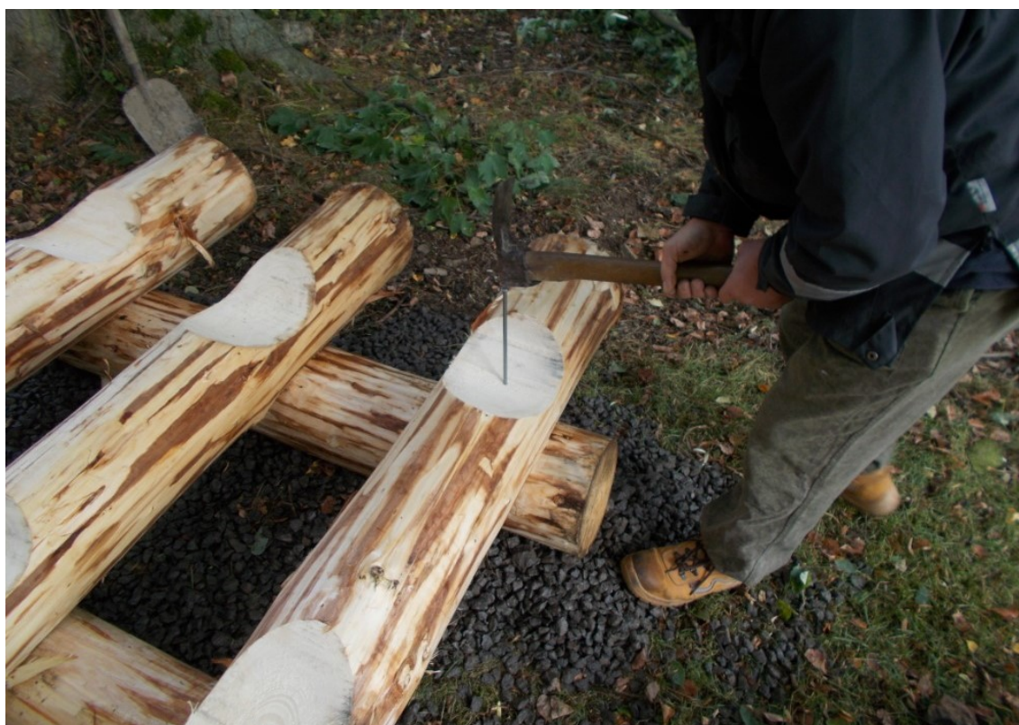
Obrázek 20 – Spojení stavebním hřebem Zdroj: vlastní
