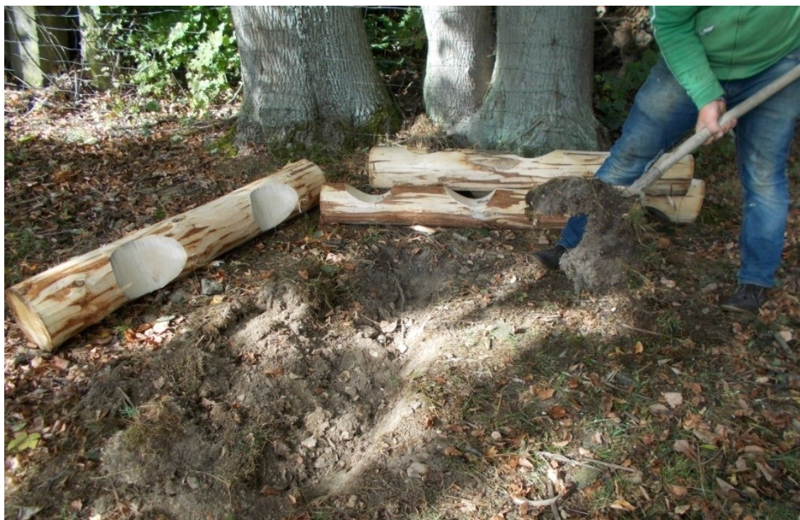
Obrázek 17 – Výkop základové rýhy Zdroj: vlastní
