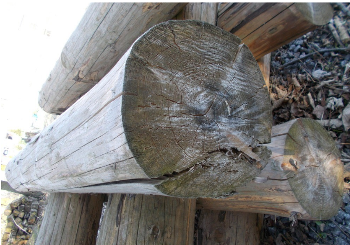
Obrázek 22 – Vytvoření výsušné trhliny Zdroj: vlastní
