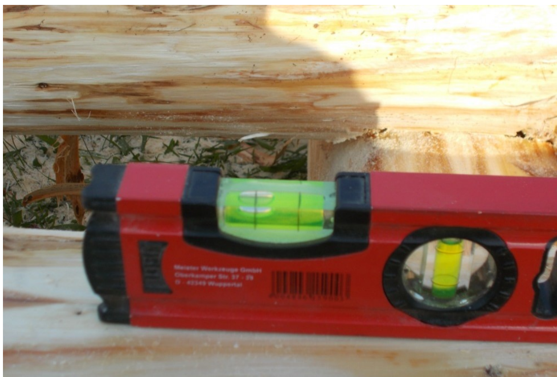
Obrázek 14 – Vyrovnání do vodorovné polohy Zdroj: vlastní
