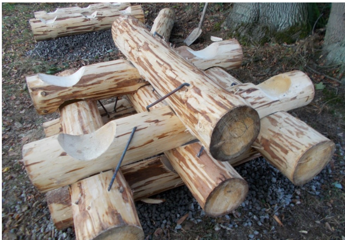
Obrázek 19 – Spojení tesařskými kramlemi Zdroj: vlastní
