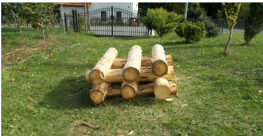
Obrázek 12 – Zkušební sesazení
