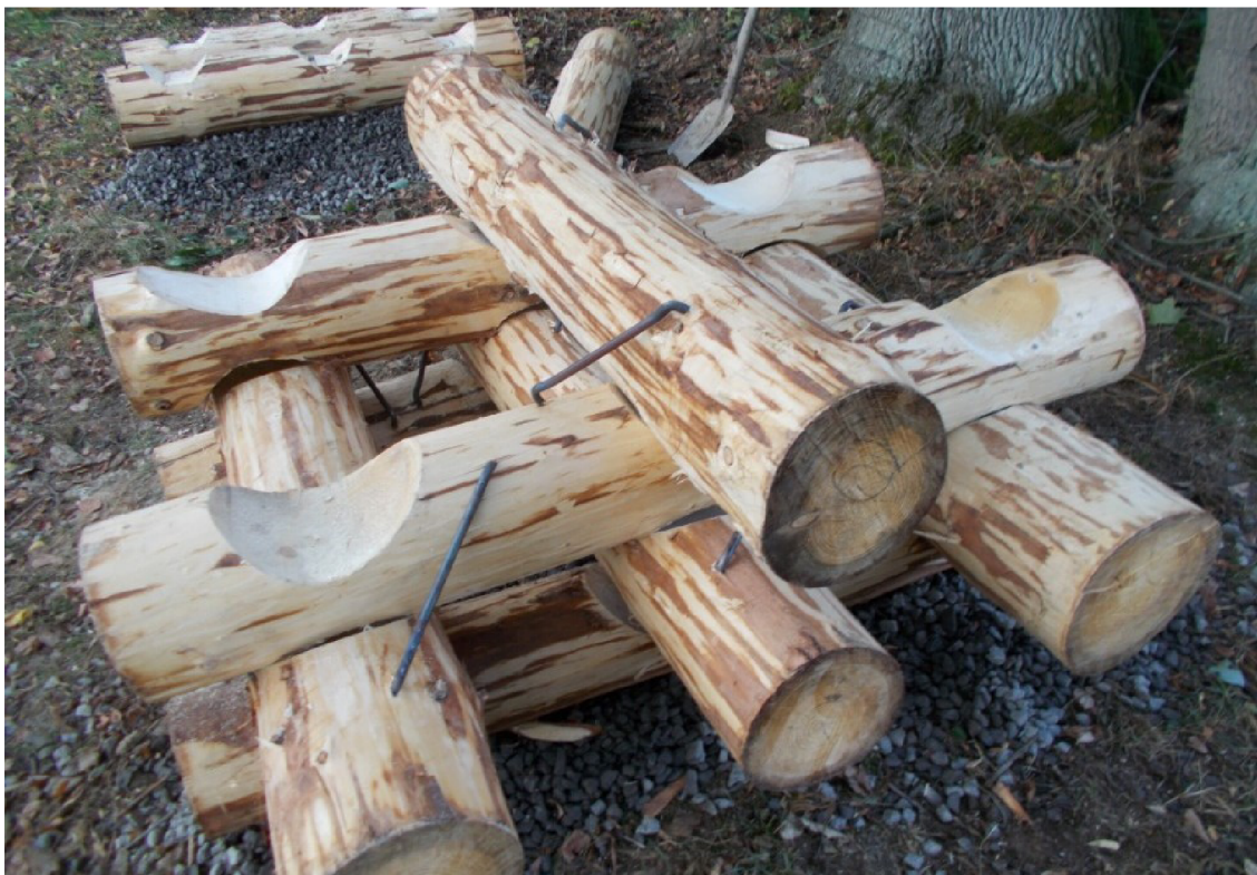
Obrázek 19 – Spojení tesařskými kramlemi Zdroj: vlastní
