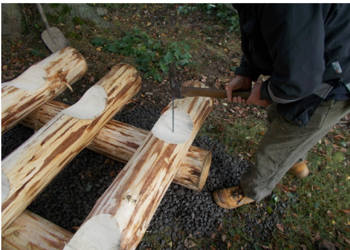
Obrázek 20 – Spojení stavebním hřebem Zdroj: vlastní
