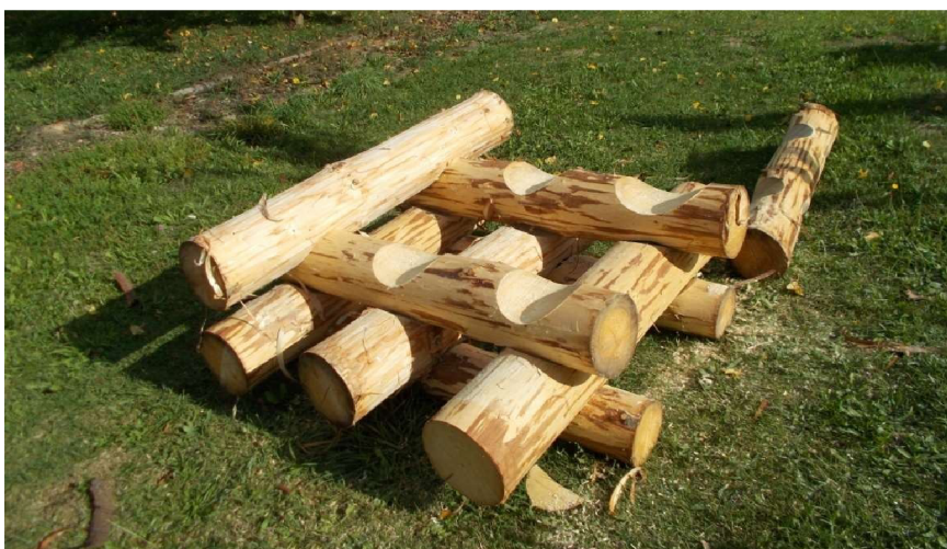
Obrázek 8 – Vzorek řezaný pásovou pilou oboustranný Zdroj: vlastní
