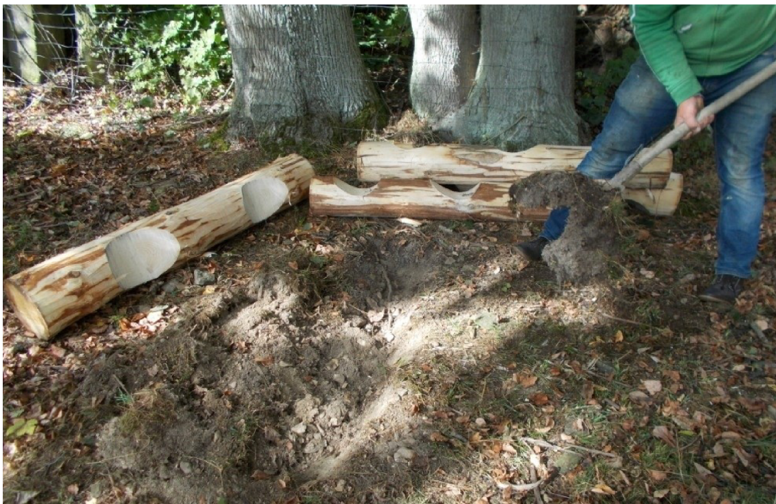
Obrázek 17 – Výkop základové rýhy Zdroj: vlastní
