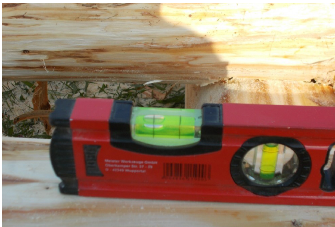
Obrázek 14 – Vyrovnání do vodorovné polohy Zdroj: vlastní
