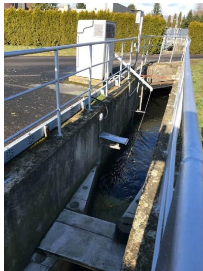
Obr. 6.11 a 6.12- Na levém obrázku je dosazovací nádrž a na pravém měrný objekt Parshallův žlab (vlastní 2019)
