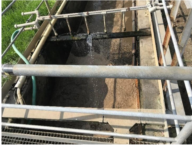
Obr. 6.16 a 6.17 - Na levém obrázku je dávkovač síranu železitého a na pravém zásobní nádrž na síran železitý (vlastní 2019)
