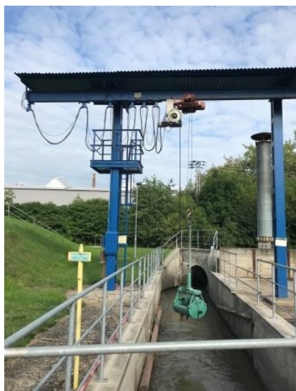
Obr. 6.1 - Přítok na ČOV Bystřany a lapák štěrku s drapákem (vlastní 2019)
