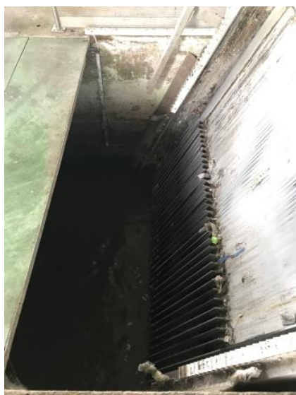
Obr. 6.2 a 6.3 - Na levém obrázku hrubé česle a na pravém jemné česle (vlastní 2019)
