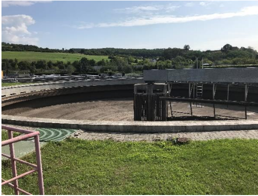
Obr. 6.6 a 6.7- Na levém obrázku je dešťová nádrž, která může sloužit i jako usazovací nádrž a na pravém usazovací nádrž (vlastní 2019)
