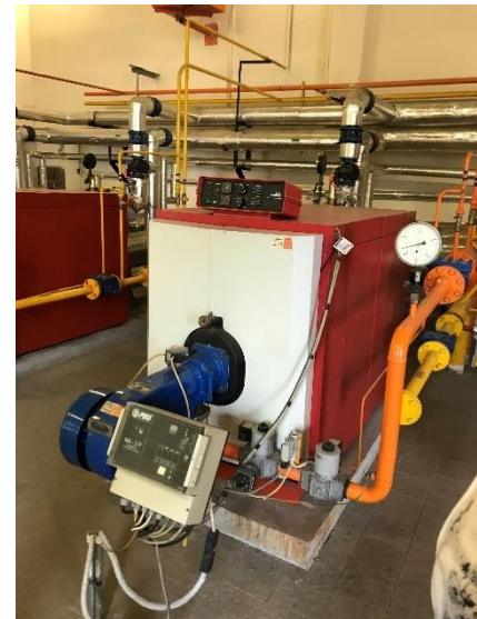
Obr. 6.18 a 6.19 - Na levém obrázku je membránový plynojem a na pravém plynový kotel-VIADRU G700 (vlastní 2019)
