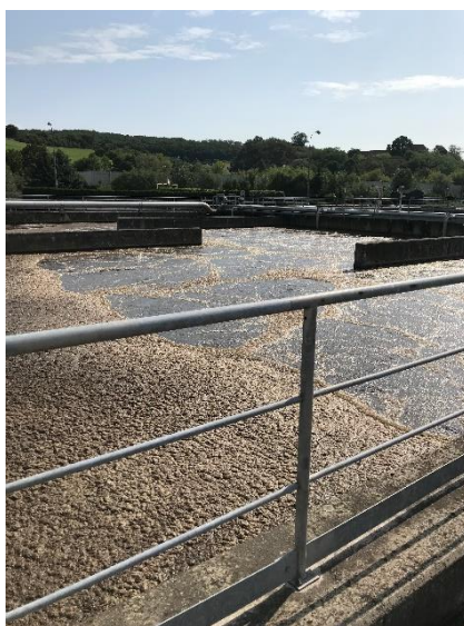
Obr. 6.10 - Nitrifikační nádrž (vlastní 2019)
