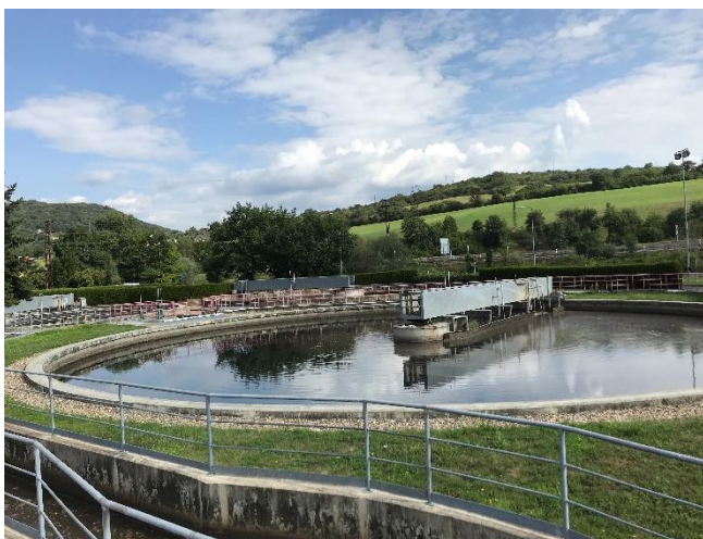
Obr. 6.11 a 6.12- Na levém obrázku je dosazovací nádrž a na pravém měrný objekt Parshallův žlab (vlastní 2019)
