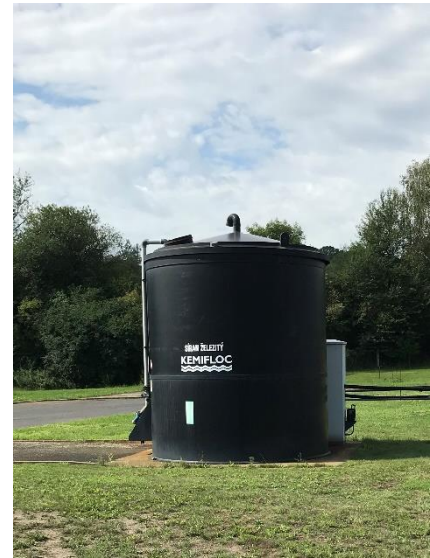
Obr. 6.16 a 6.17 - Na levém obrázku je dávkovač síranu železitého a na pravém zásobní nádrž na síran železitý (vlastní 2019)
