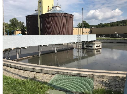
Obr. 6.6 a 6.7- Na levém obrázku je dešťová nádrž, která může sloužit i jako usazovací nádrž a na pravém usazovací nádrž (vlastní 2019)
