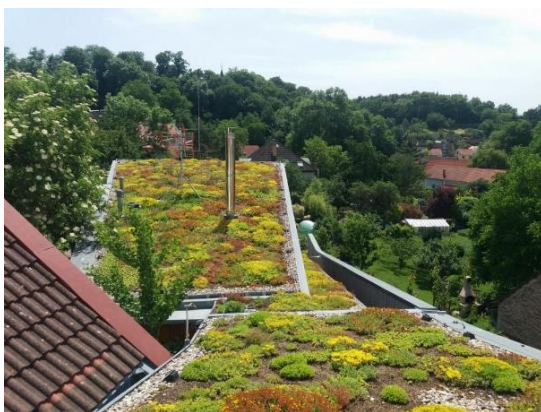
Obrázek 2: extenzivní zelená střecha v Úžině (Dostál, 2020)
