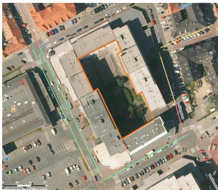
Obrázek 10: vnitroblok panelového domu v Tyršově ulici na Kladně (mapy.cz, 2024)
