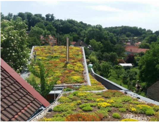
Obrázek 2: extenzivní zelená střecha v Úžině (Dostál, 2020)
