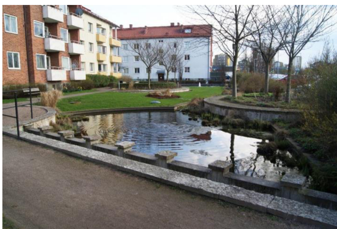
Obrázek 8: retenční nádrž před bytovým domem v Augustenborgu (Folkesson, 2023)
