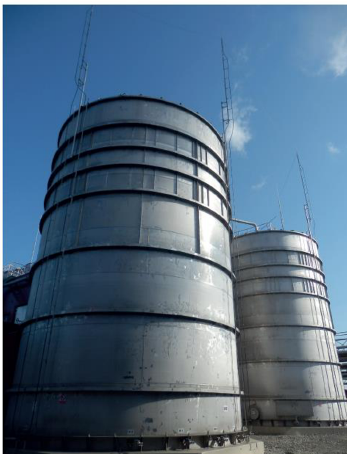
Obrázek 14: Instalace vodiče HVI long v prostředí s nebezpečím výbuchu [22]
