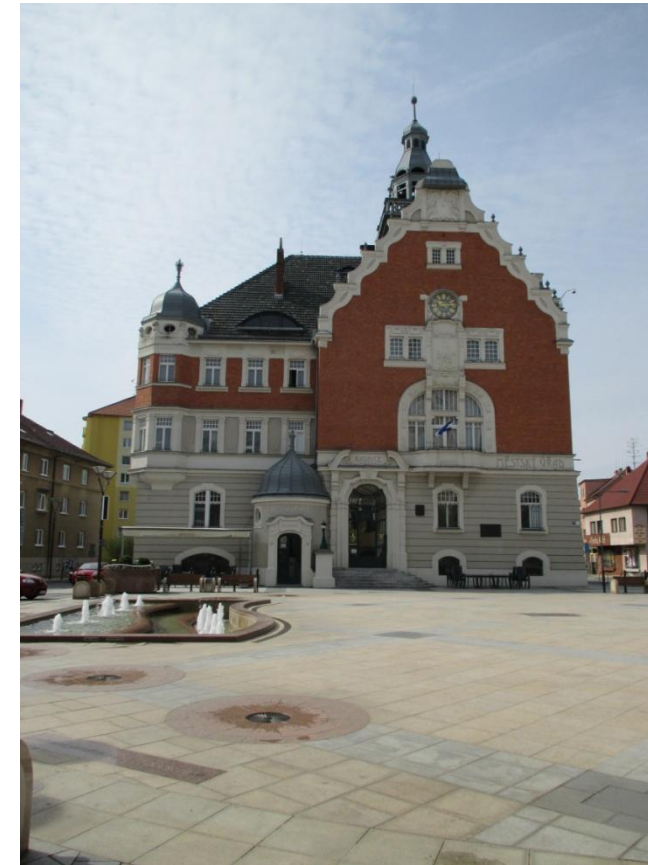
Obr. 11- Pohled na radnici (foto: autor, 2015)
