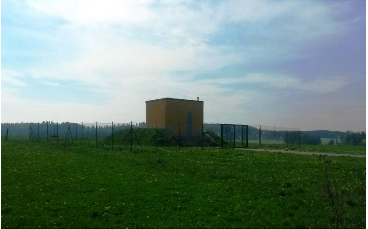
Příloha č. 14 Vodárna
