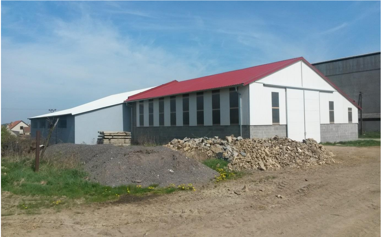
Příloha č. 10 Zemědělská budova
