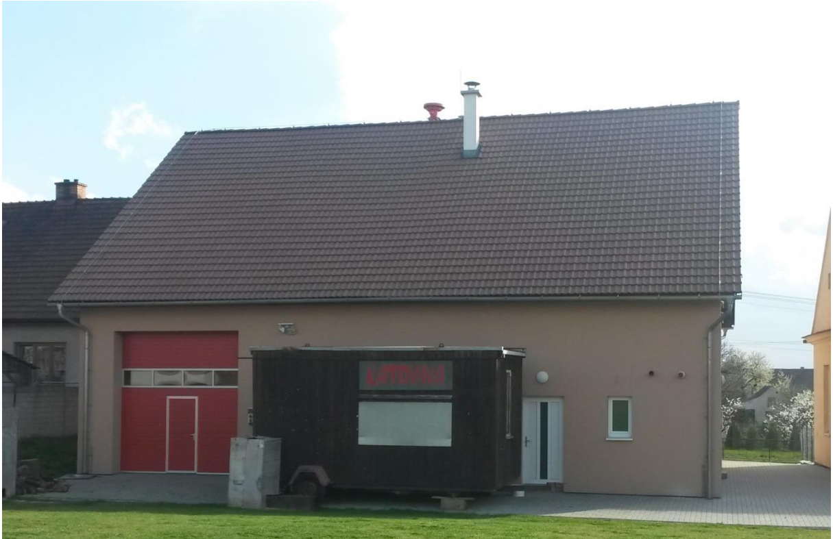
Příloha č. 4 Hasičská zbrojnice – zadní pohled
