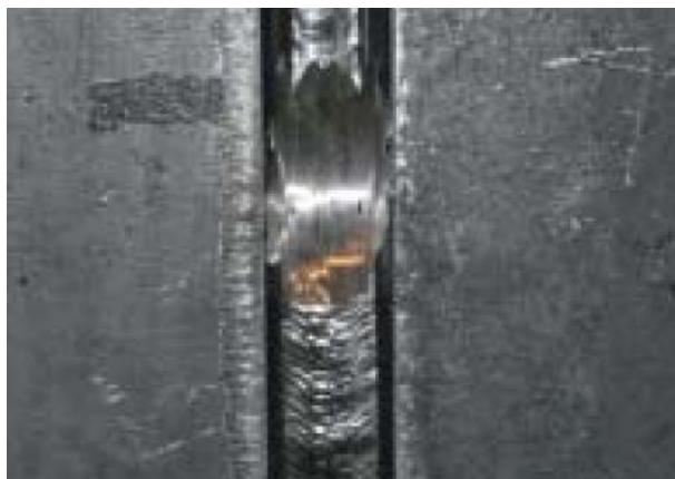
Obr. 53. Ukázka vybroušení místa k napojení svarové vrstvy. [4]
