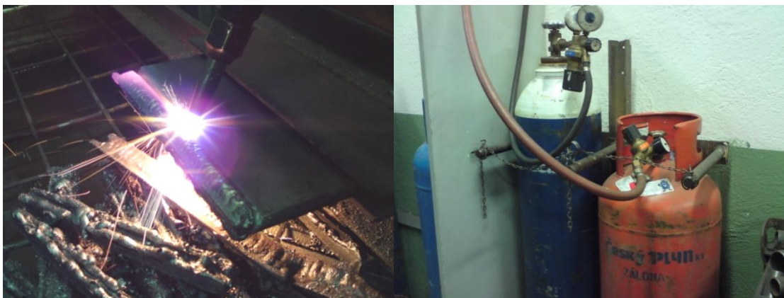
Obr. 38 Řezání kyslíkovým-propan-butanovým plamenem s patřičnou soupravou.
