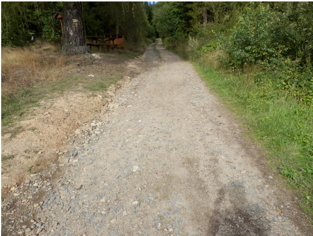
Začátek úseku rekonstrukce lesní odvozní cesty
