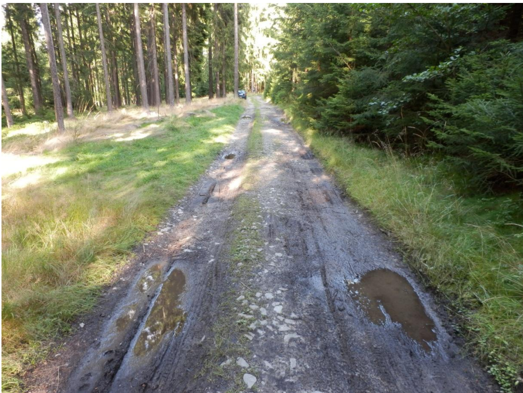
Vyjeté koleje se stagnující vodou a vlevo potenciální místo druhé skládky
