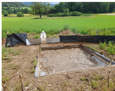
Obrázek 36 - vyčištěná a upravená jímka č. 1, zdroj vlastní
