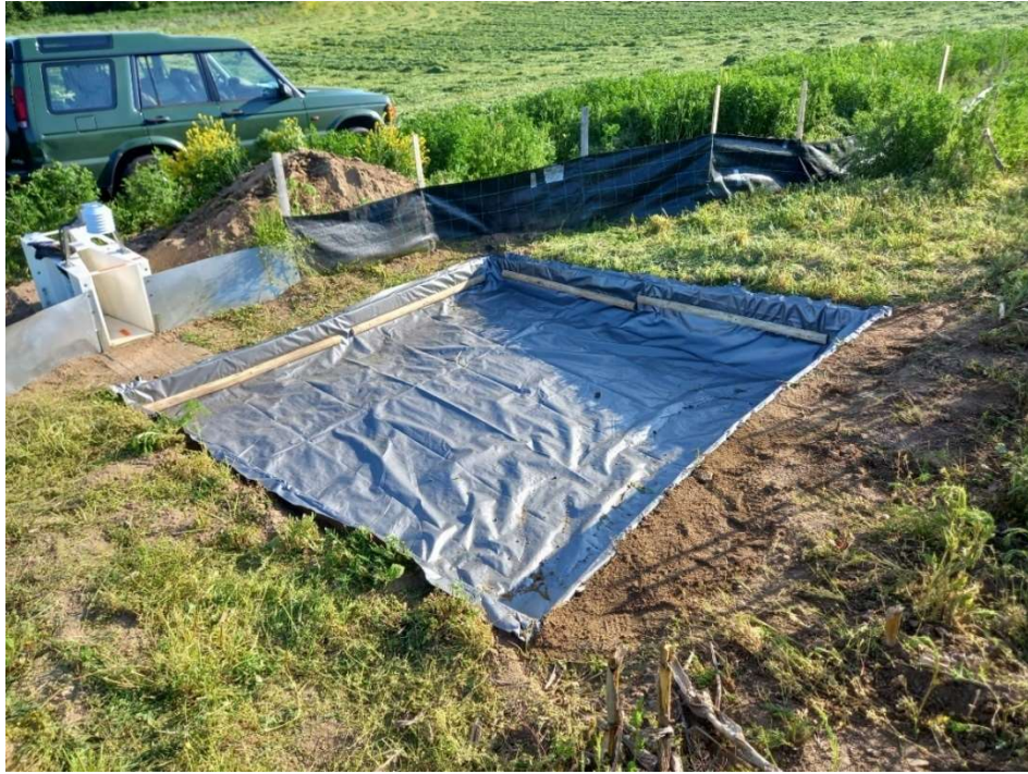
Obrázek 12 - sedimentační jímka po opravě - zdroj vlastní
