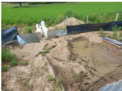
Obrázek 35 - jímka č. 1 před vyčištěním, zdroj vlastní
