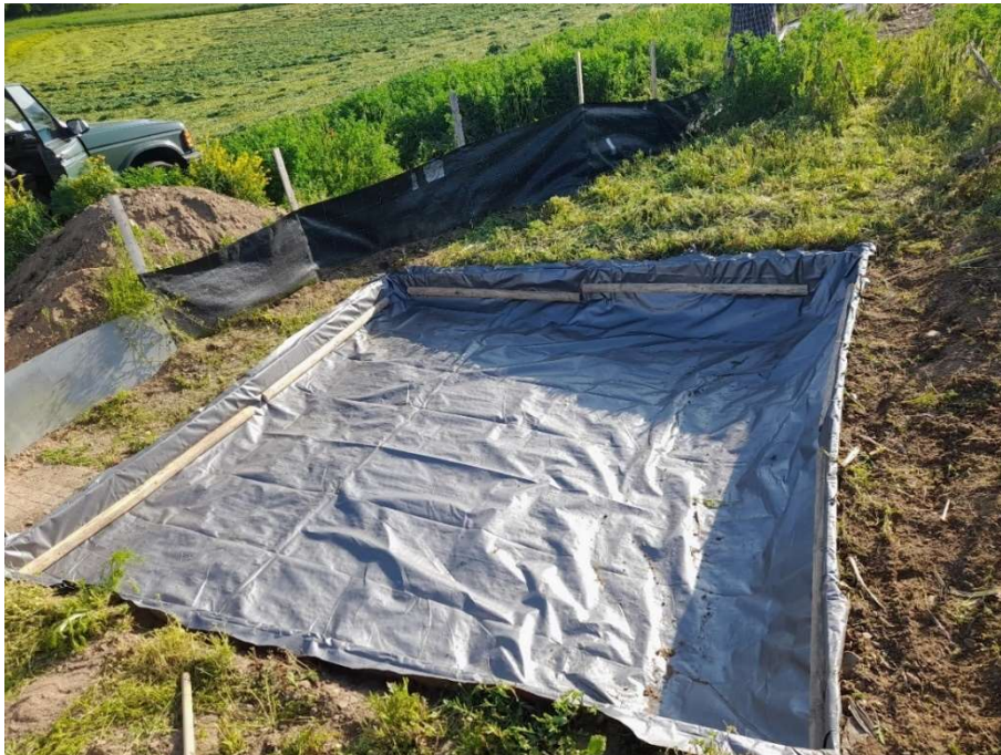
Obrázek 4 - sedimentační jímka, zdroj vlastní
