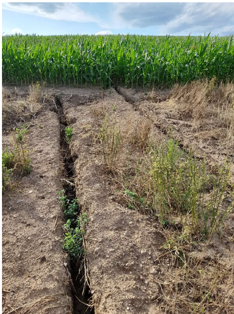
Obrázek 16 - svodné rýhy po 2. opravě lokality – zdroj vlastní
