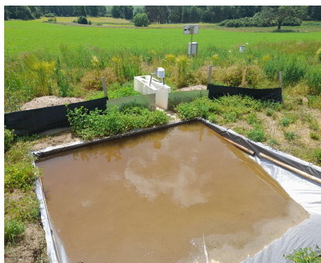
Obrázek 40 - jímka č. 3 před vyčištěním - zdroj vlastní
