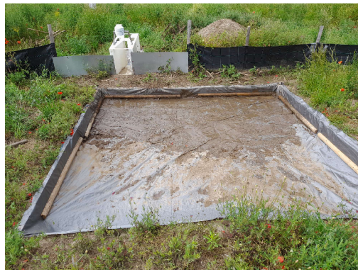
Obrázek 38 - jímka č. 2 po vyčištění, zdroj vlastní
