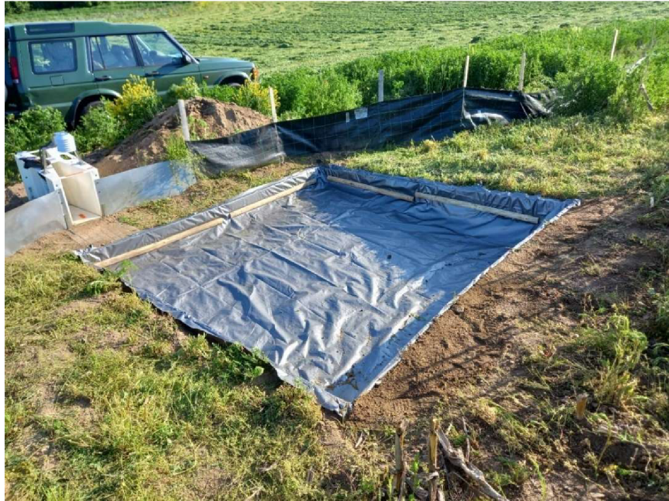
Obrázek 12 - sedimentační jímka po opravě - zdroj vlastní
