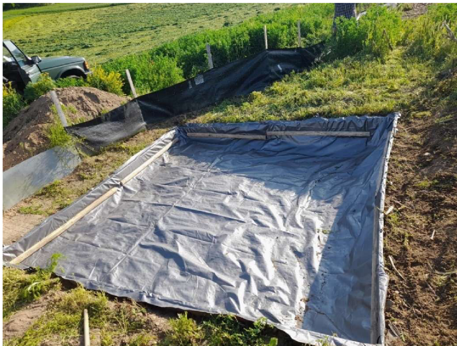
Obrázek 4 - sedimentační jímka, zdroj vlastní
