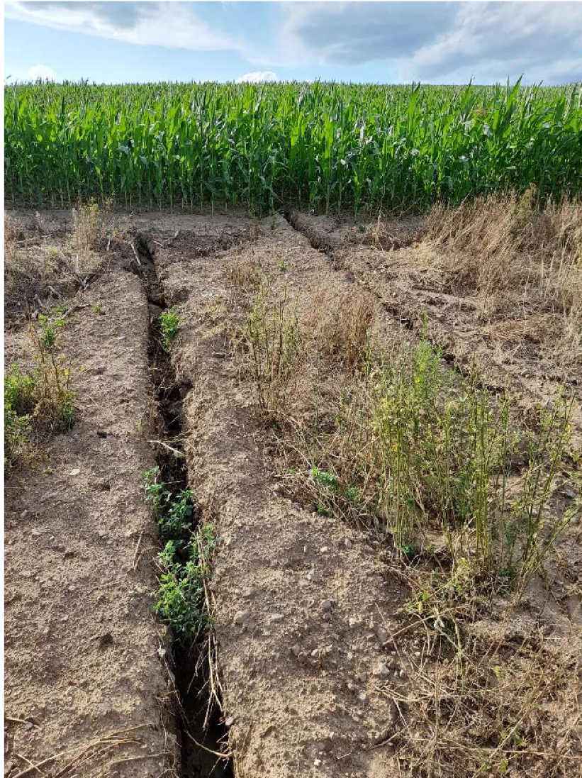
Obrázek 16 - svodné rýhy po 2. opravě lokality – zdroj vlastní
