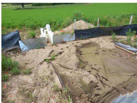
Obrázek 35 - jímka č. 1 před vyčištěním, zdroj vlastní
