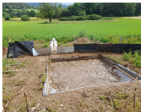
Obrázek 36 - vyčištěná a upravená jímka č. 1, zdroj vlastní
