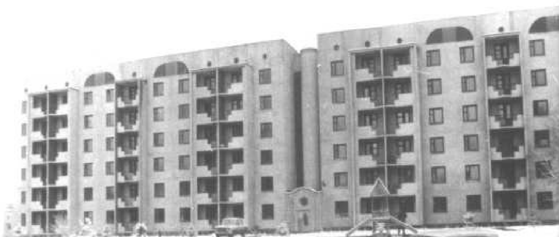
Obrázok 7: Bytový dom z roku 1990 postavený z popolčekového a troskového alkalického materiálu v Rusku v meste Novokuznetsk [26]
