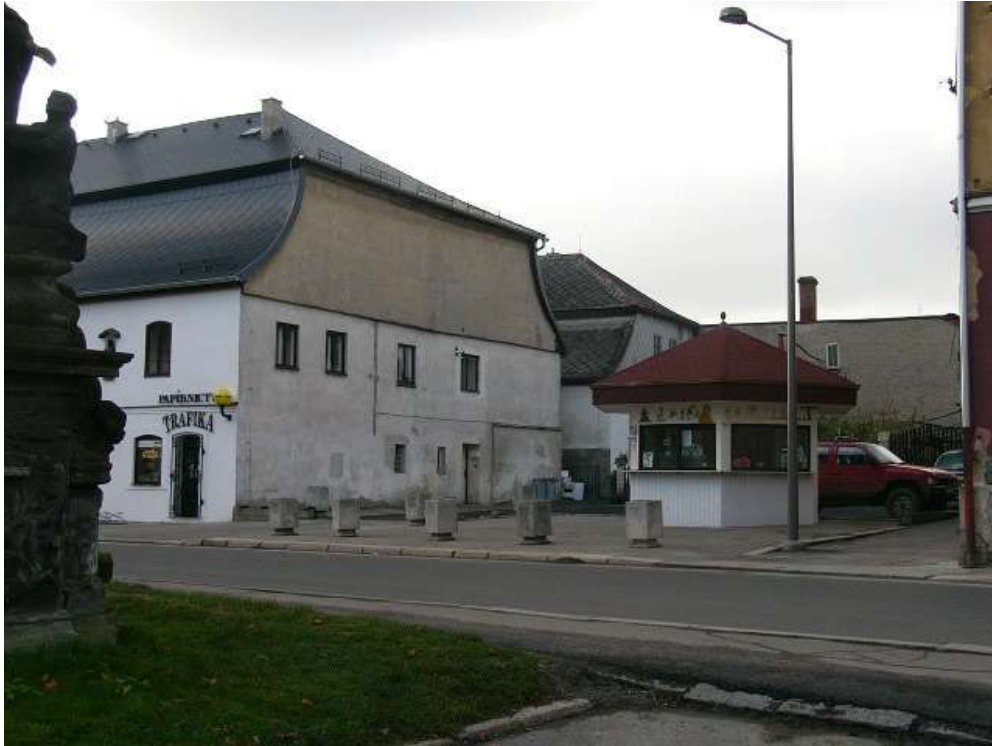
Obr. č. 19: Od Dominikánského náměstí vede cesta i do další části historického centra. Toto je její využití.
