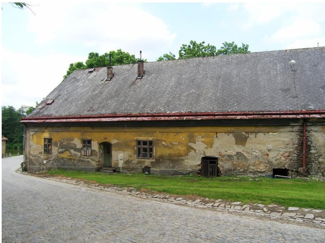
Obr. 5: Budova pivovaru Žirovnice před revitalizací
