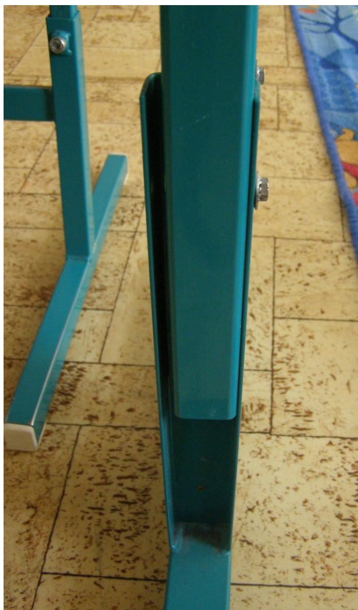
Obr. 51 - Čelní pohled na konstrukci výškového nastavení
