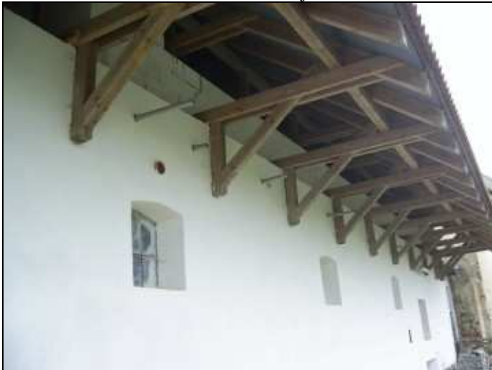
Obrázek č.28 : Zrekonstruovaná stáj – Statek Horní Dvorce
