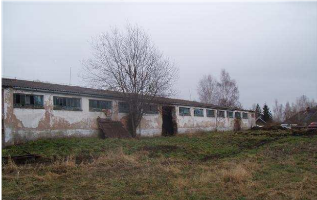
Obrázek č. 29: Stáj před rekonstrukcí – Farma Čeřín
