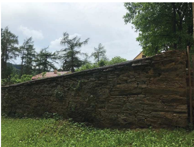
Horské Domky, kamenné zdi Souřadnice stanoviště 13° 3' 57.889" V, 49° 49' 44.718" S Aneta Matoušková 2022-06-05
