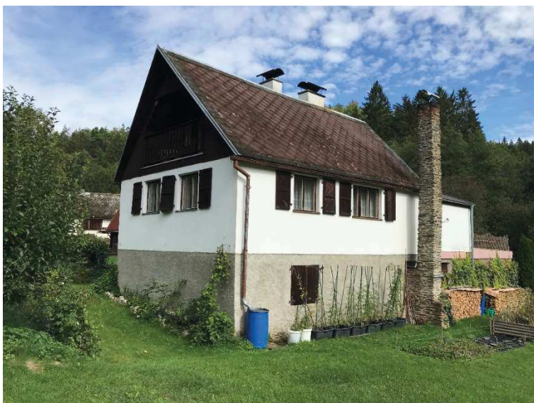
Hlaváčkův mlýn, pohled od příjezdové cesty Souřadnice stanoviště 13° 1' 47.330" V, 49° 52' 49.139" S Aneta Matoušková 2022-09-17
