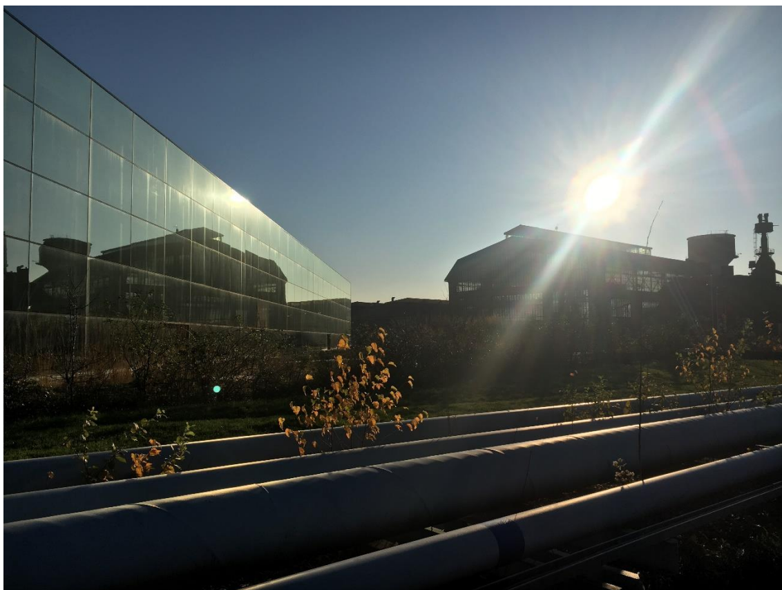
Obr. č. 58 – Nově vystavěná budova Svět techniky v areálu DoV, říjen 2018
