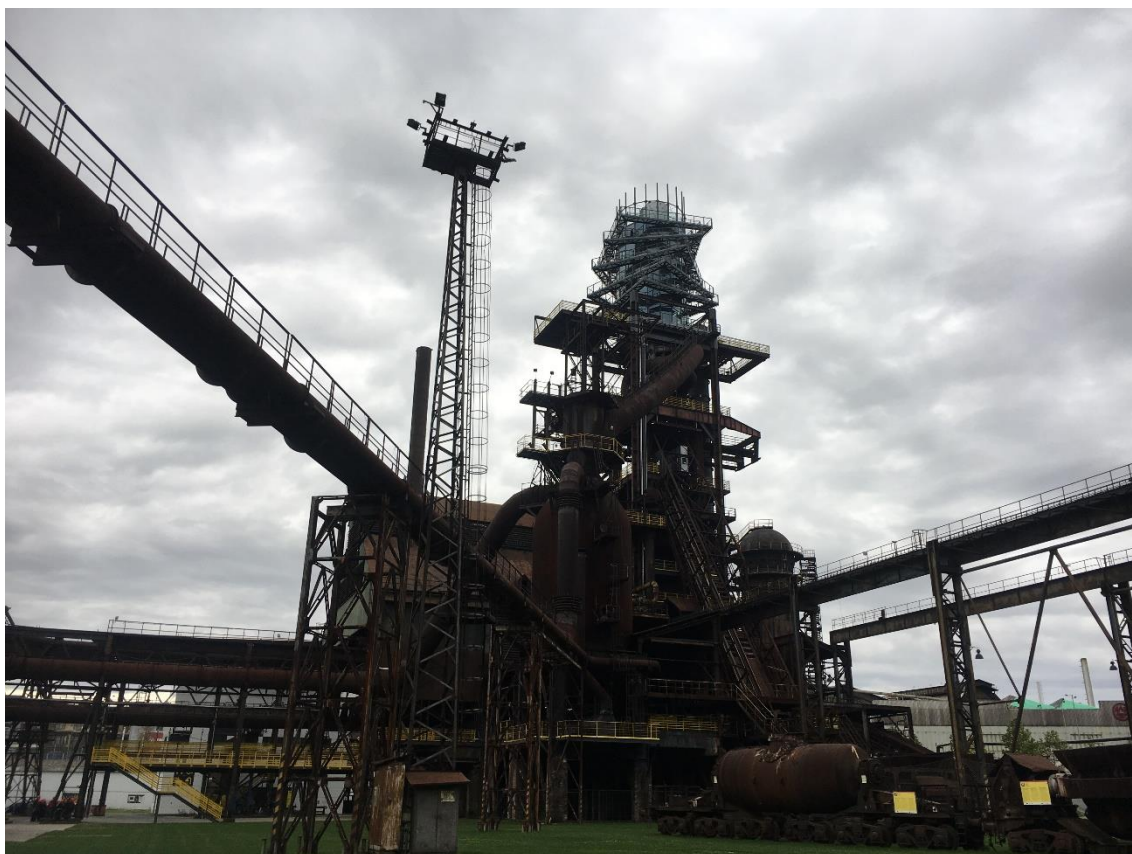
Obr. č. 62 – Pohled na Bolt tower a Vysokou pec č. 1, září 2017
