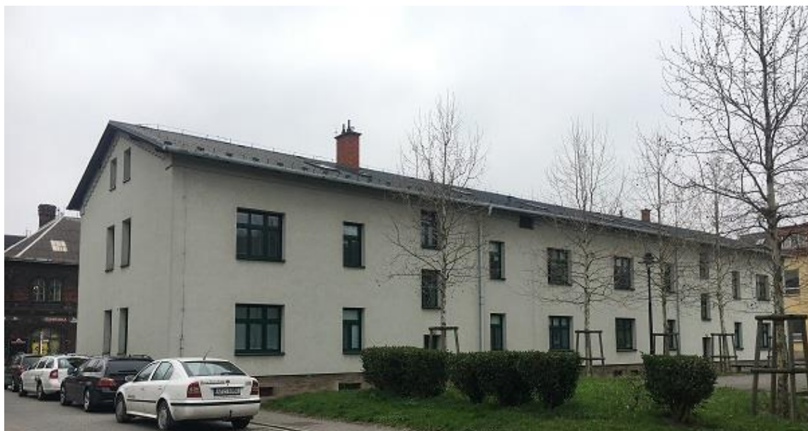
Obr. č. 42 – Pohled na jeden ze čtyř domů kolonie, duben 2019
