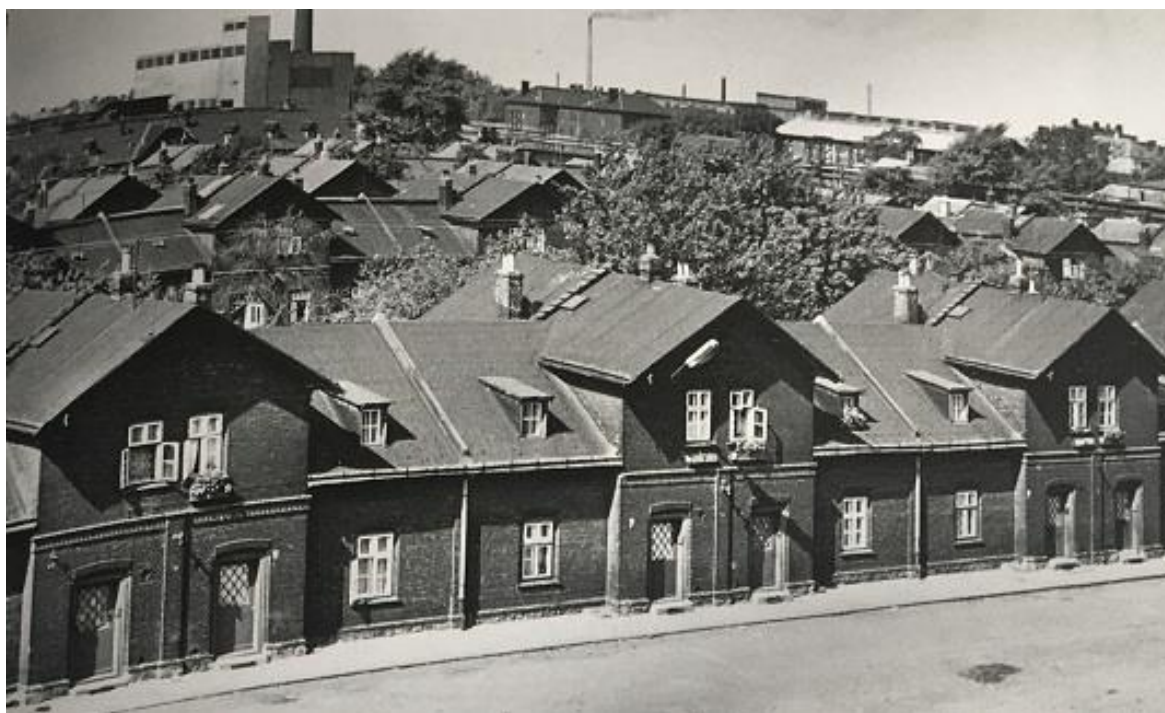
Obr. č. 34 – Domy v Štítové kolonie 1971 (Zdroj: AMO)
