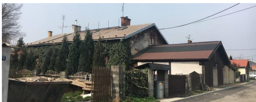
Obr. č. 19 – Pohled na dům Josefské kolonie, březen 2019
