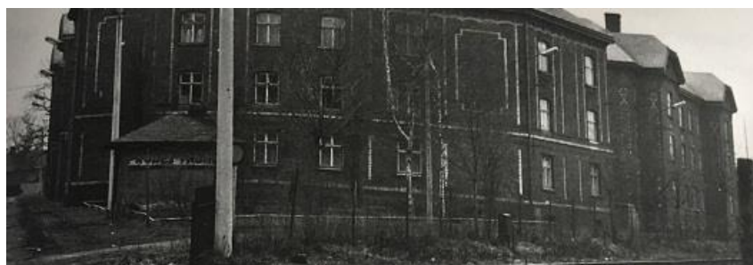
Obr. č. 49 – Budova Sirotčí kolonie za železniční tratí v 70. letech 20. stol. (zdroj: AMO)
