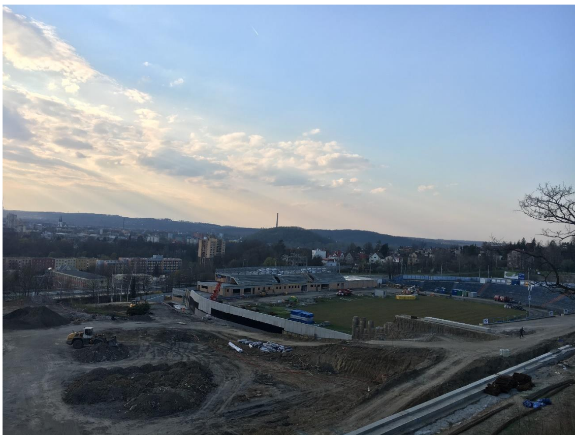
Obr. č. 71 – Pohled z mostu nad Bazalama na Moravskou Ostravu a právě probíhající rekonstrukci, březen 2019
