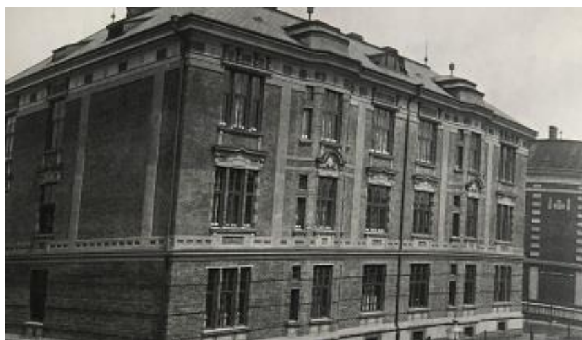
Obr. č. 38 – Obytný dům úřednické kolonie r. 1913 (Zdroj: AMO)
