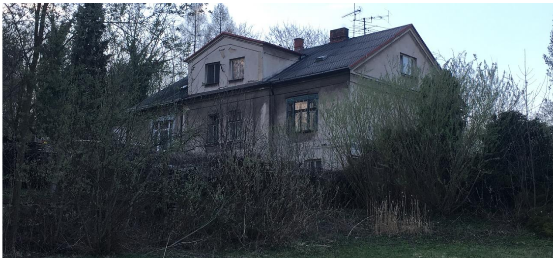
Obr. č. 8 - Pohled na úřednickou vilu hornické kolonie Michálka, březen 2019
