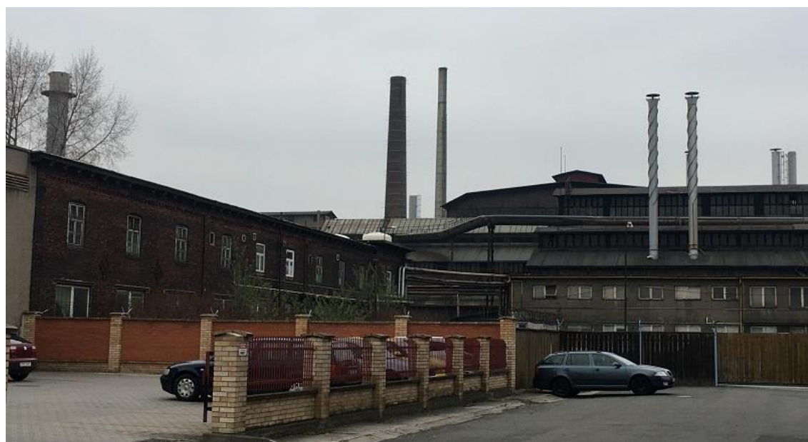
Obr. č. 52 – Budova půdorysu L kolonie Kairo a za ní areál Vítkovických železáren, 2019
