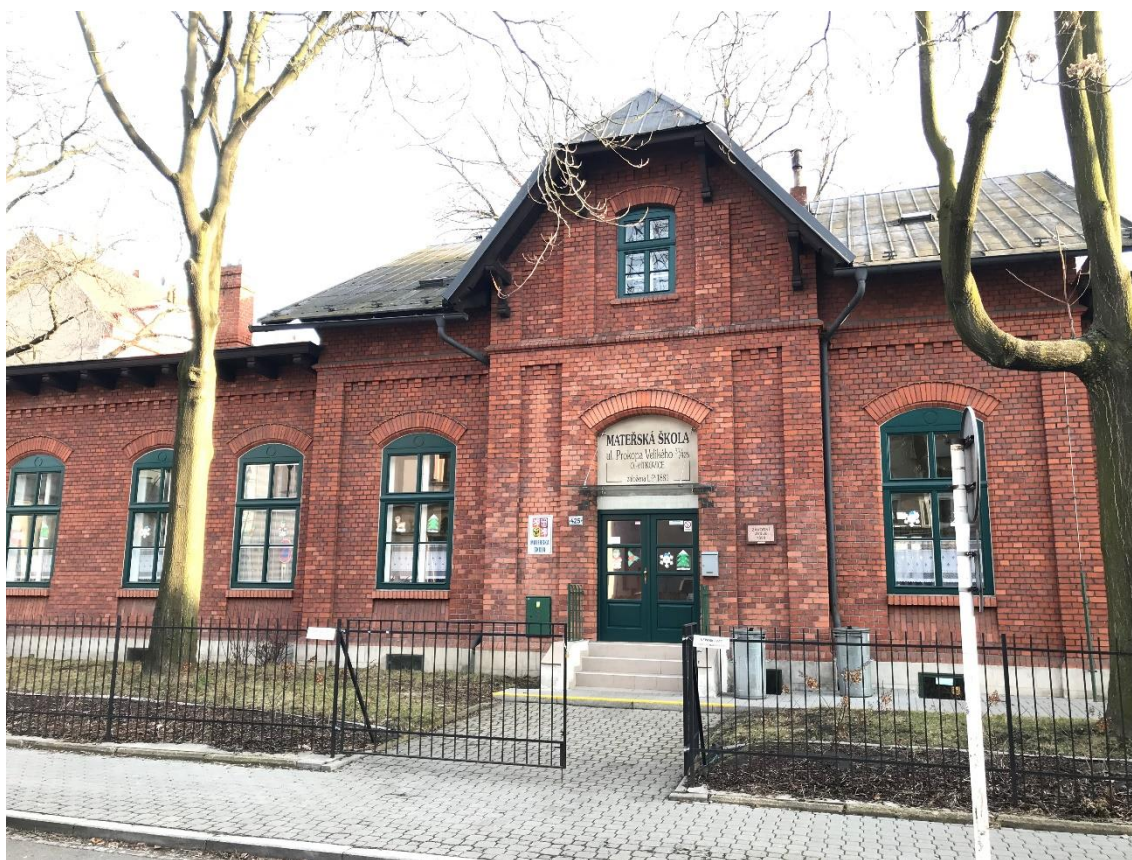
Obr. č. 55 – Matěřská škola Ostrava Vítkovice, březen 2019
