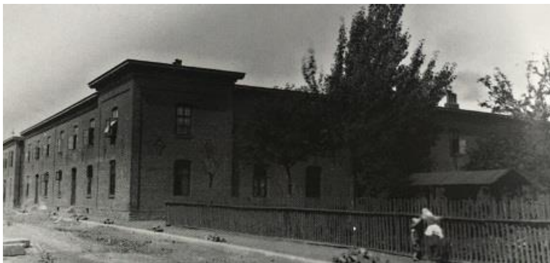
Obr. č. 51 – Budova půdorysu L kolonie Kairo 1902 (AMO)
