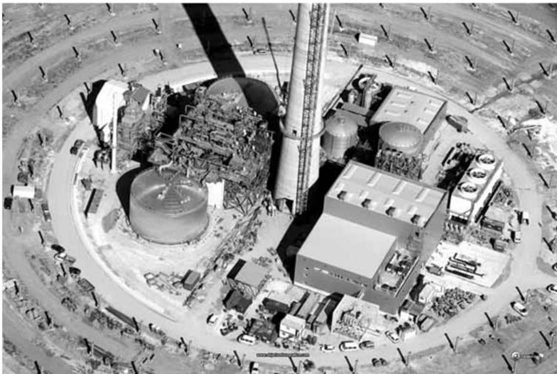
Obr. 4-4: Dvou nádržový skladovací systém 17MWel Gemasolar elektrárny s centrálním přijímačem, Španělsko [6] (s povolením Torresol Energy, Španělsko).
