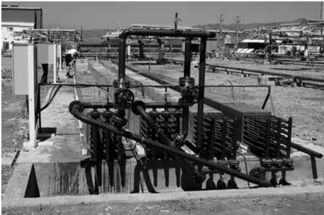
Obr. 4-7: Betonový skladovací modul před instalací izolace [6].
