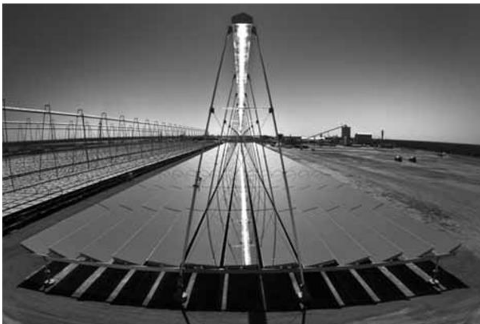
Obr. 3-2: Čtvrtá linie v Kimberlina za provozu. Pracuje jako přehřívací linie na 400 °C [9] (s povolením Areva Solar).
