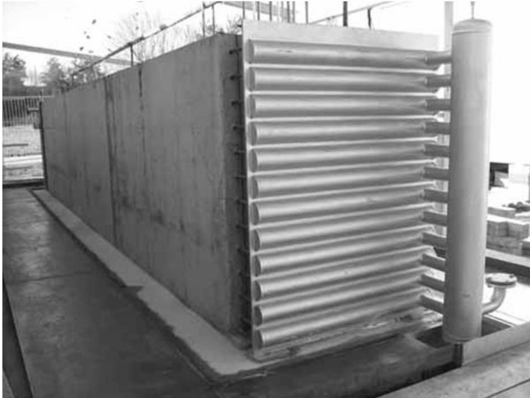
Obr. 4-8: Betonový skladovací modul (400 kWh) před instalací izolace [6].
