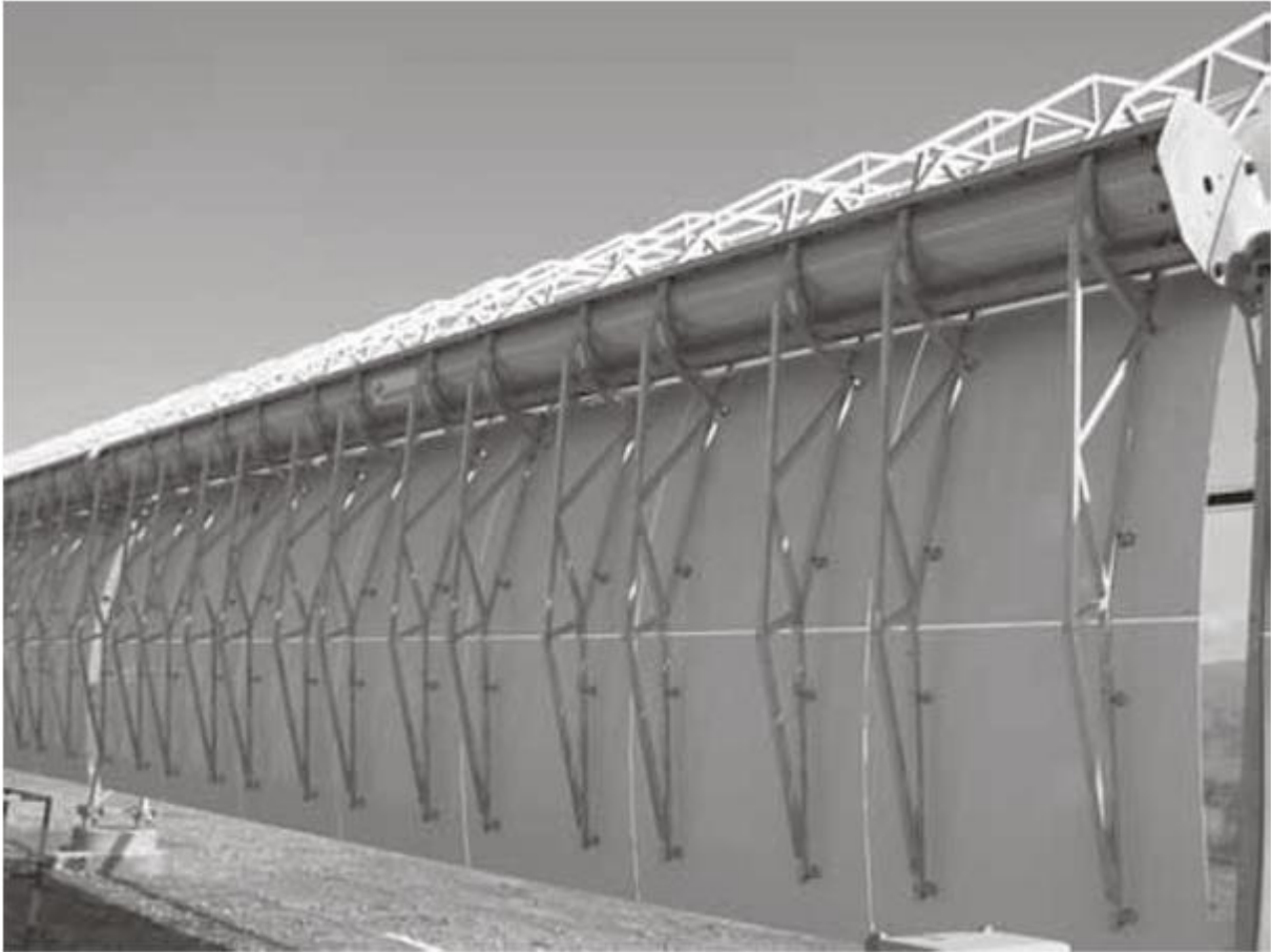
Obr. 3-8: PTC design s torzní trubkou k zajištění dobré torzní tuhosti [14].
