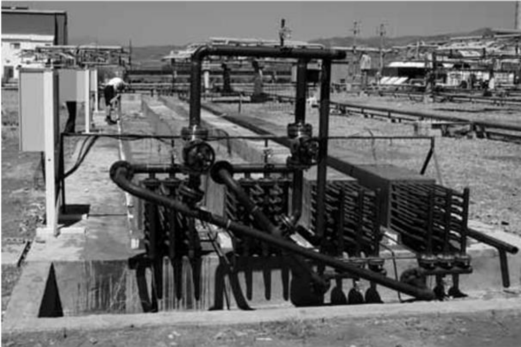
Obr. 9: Betonový skladovací modul před instalací izolace (Steinmann, 2012).
