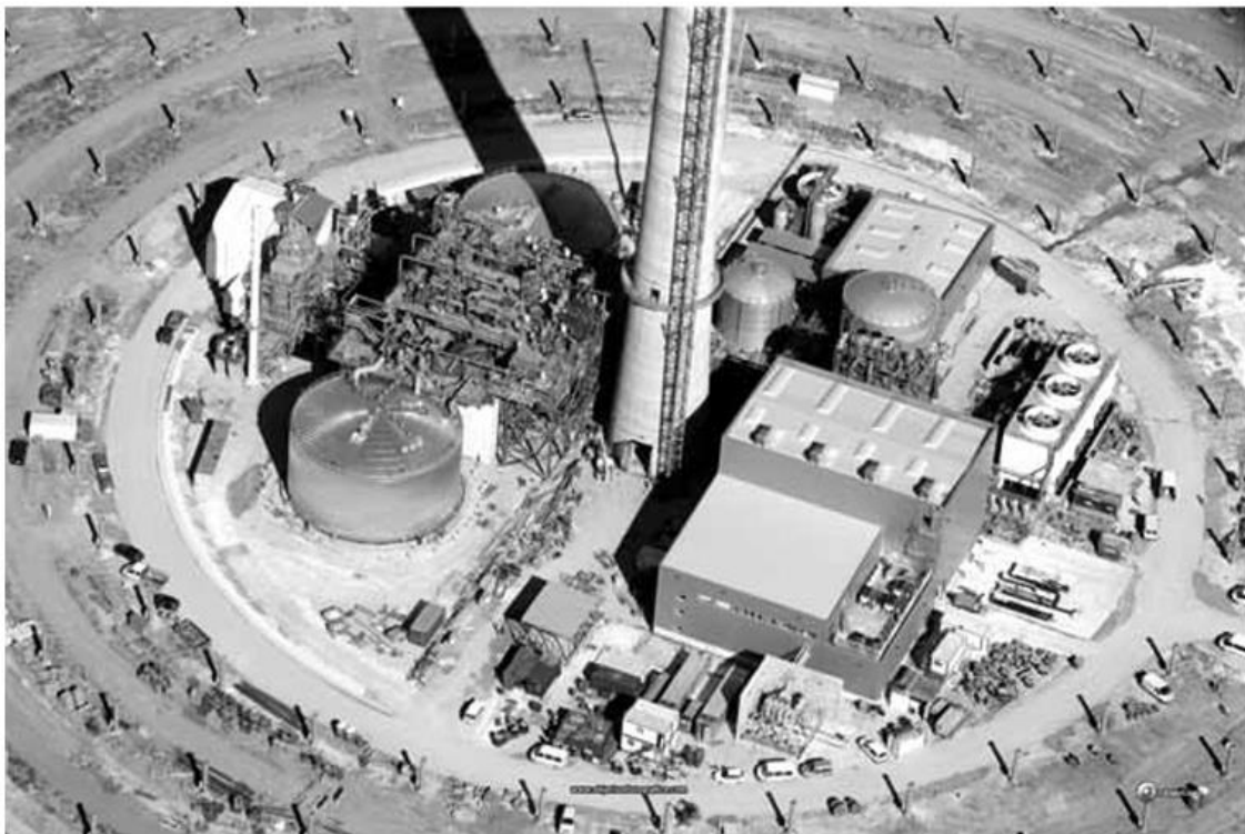
Obr. 6: Dvou nádržový skladovací systém 17MW e Gemasolar elektrárny s centrálním přijímačem, Španělsko (v Steinmann, 2012 s povolením Torresol Energy, Spain).
