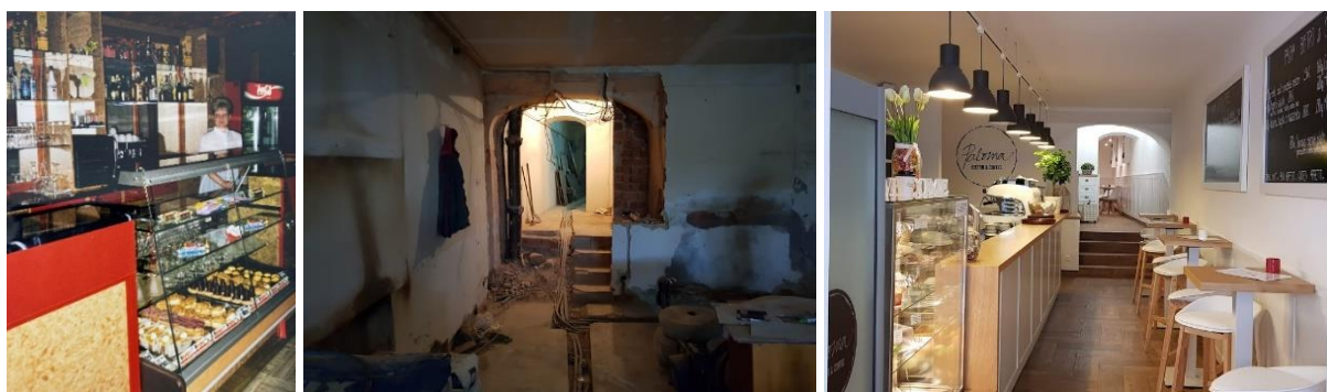
Obr. 4 Rekonštrukcia v roku 2018
