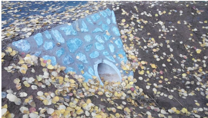
Obr. 10: Propustek - lesní cesta „Okružní“
