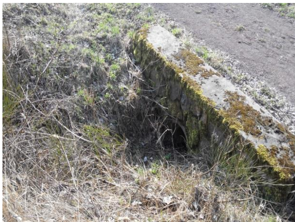
Obř. 7: Zanesený propustek - lokalita „Poříčský hřbet“
