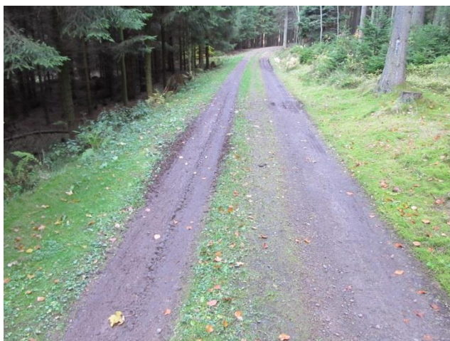
Obr. 11: Vytlačený okraj vozovky - lesní cesta „Od obrázku“
