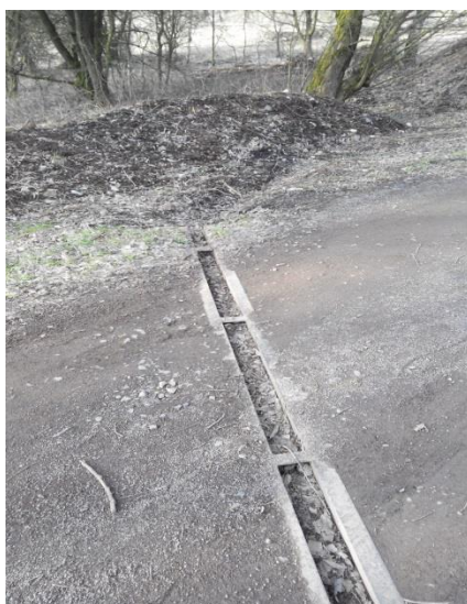
Obr. 1: Zanesená ocelová svodnice
