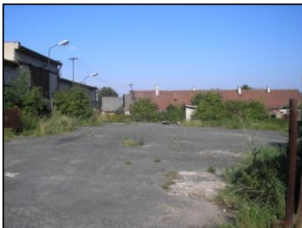
Foto 15, 16: Chátrající areál bývalého JZD v sídle Kaliště
