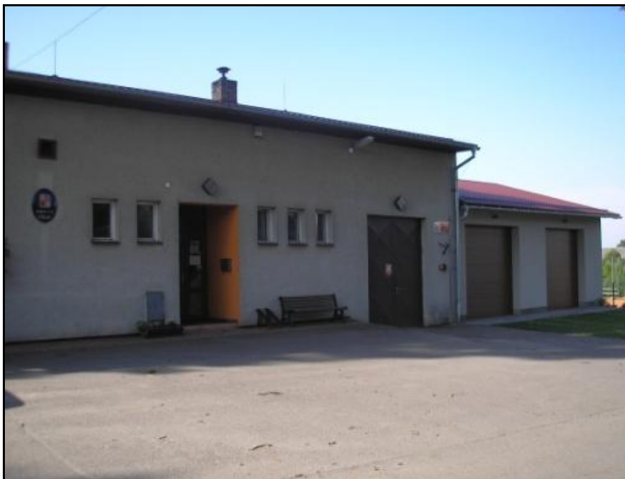
Foto 6: Obecní úřad a hasičská zbrojnice na návsi v sídle Kaliště
