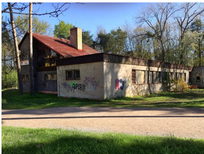
Obrázek 11: Objekt lesoparku navržen na demolici
