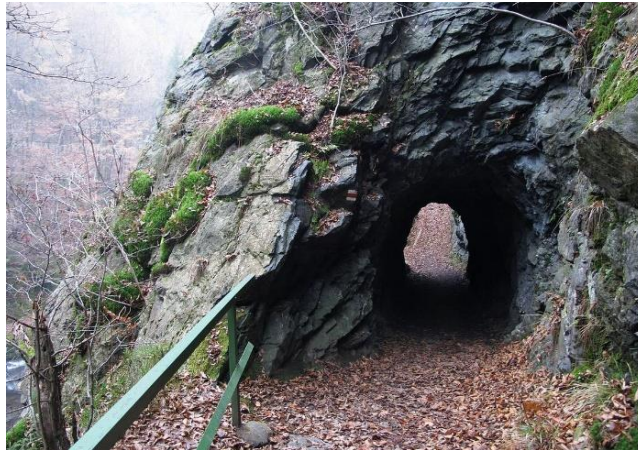
Obrázek 24 - Tunel na Riegrově stezce
