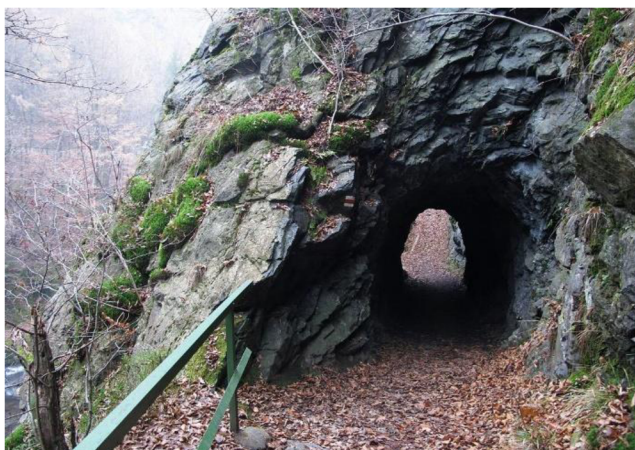
Obrázek 24 - Tunel na Riegrově stezce
