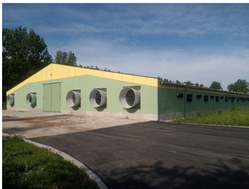
Obrázek 3.2: Čelní pohled na halu C
