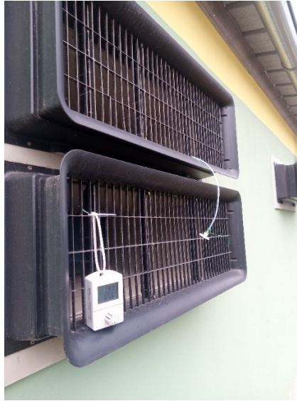
Obrázek 3.5: Venkovní pohled směrových klapek se sondou vstupního vzduchu a Loggerem S3120
