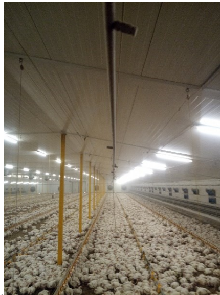
Obrázek 3.6: Chladící trubice s tryskami
