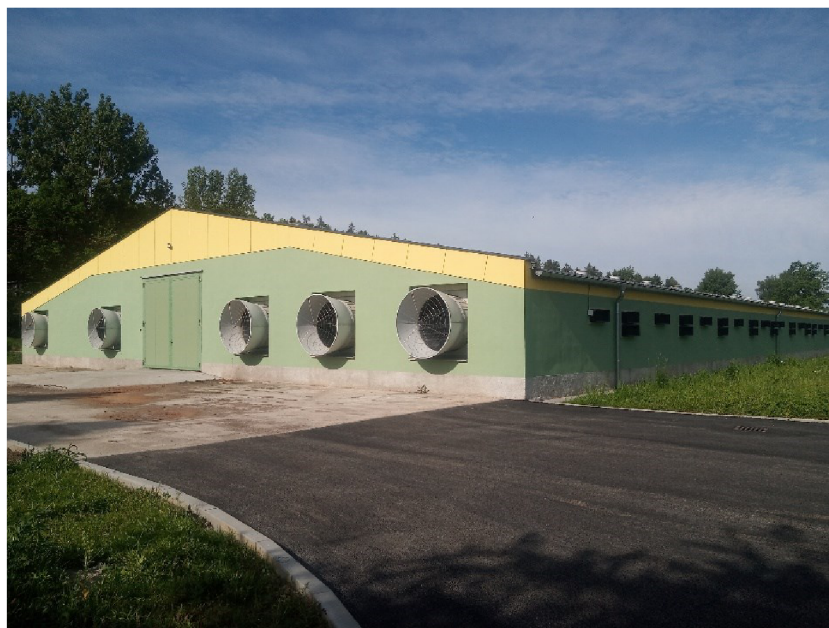
Obrázek 3.2: Čelní pohled na halu C
