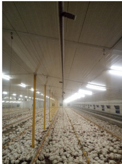
Obrázek 3.6: Chladící trubice s tryskami
