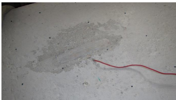
Obr. P5-18: Upravená plocha betonu pro lepení odporového tenzometru a vodič odporového tenzometru oceli
