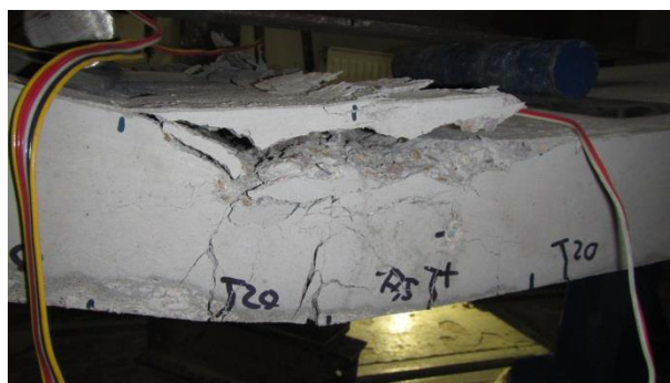
Obr. P5-29: Tlakové porušení betonu
