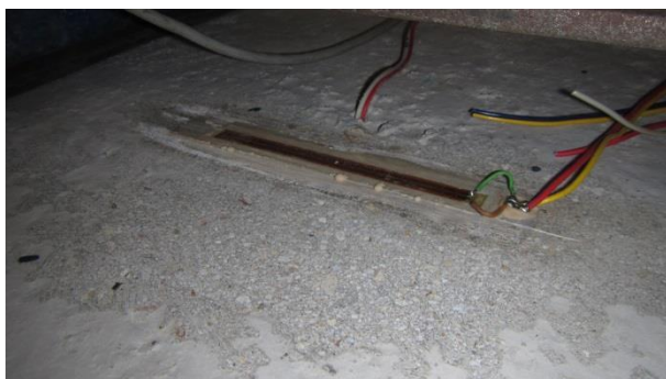
Obr. P5-24: Nalepený odporový tenzometr pro záznam napětí v tlačené části betonu
