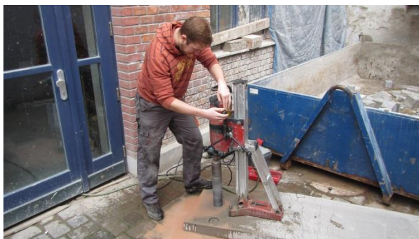
Obr. P5-32: Odebírání jádrových vývrtů
