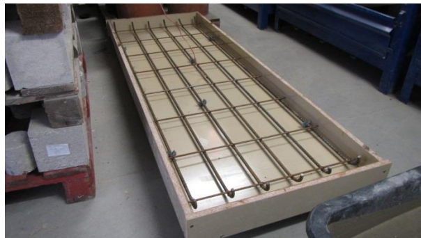
Obr. P5-2 Sestavené bednění s usazeným armokošem
