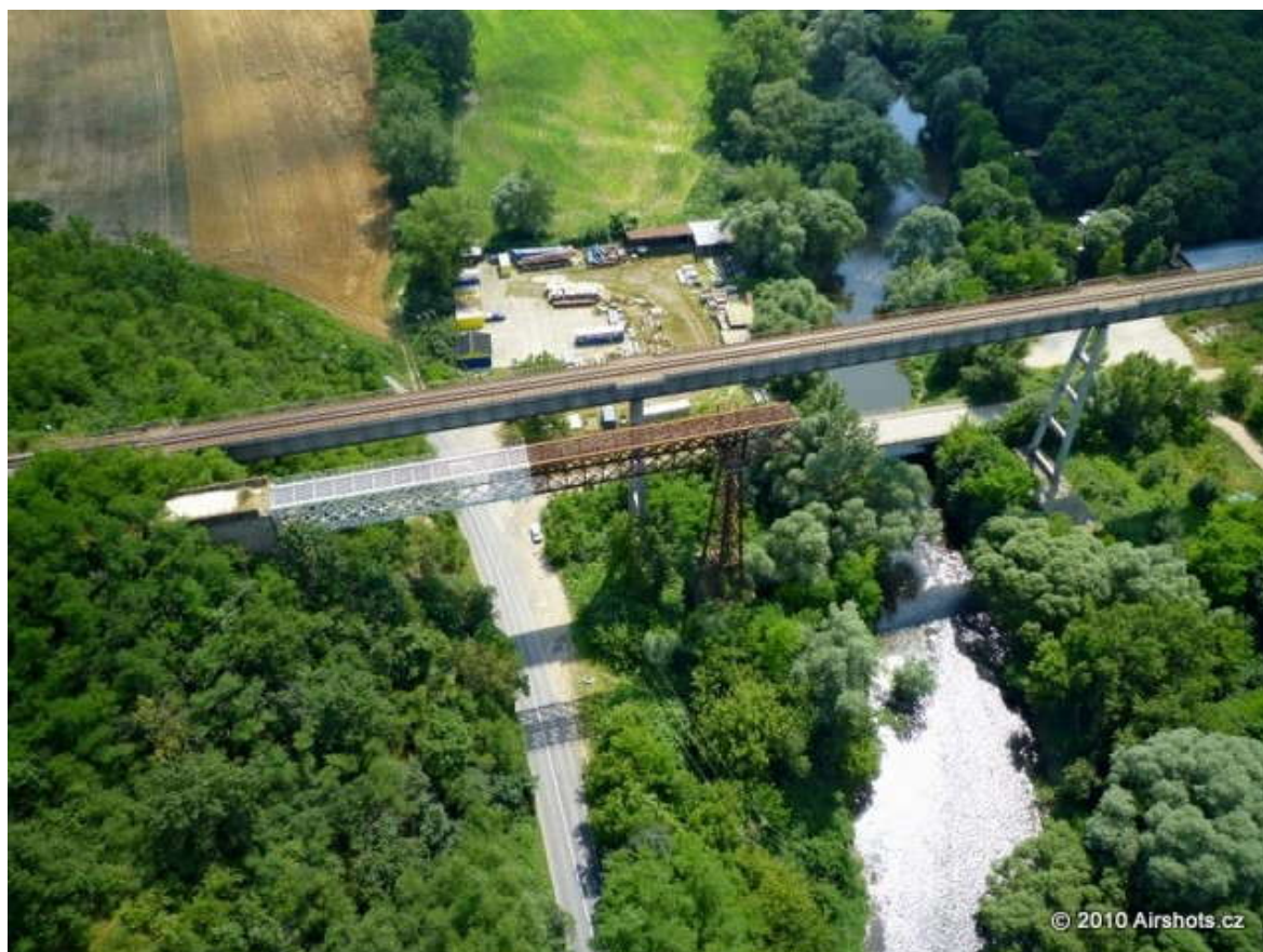
Obrázek 1.1 Letecký snímek nového mostu a zachované části starého mostu.
