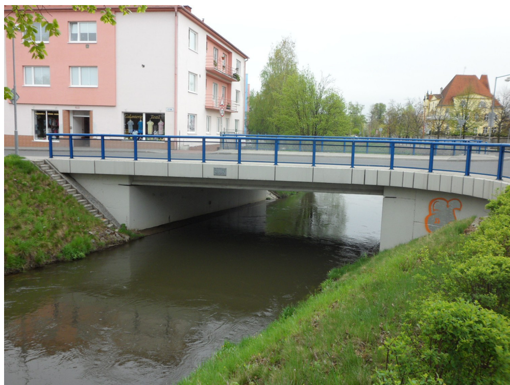
Příloha č. 24: Rekonstruovaný most přes Elektrárenský náhon v Litovli, ulice Vítězná
