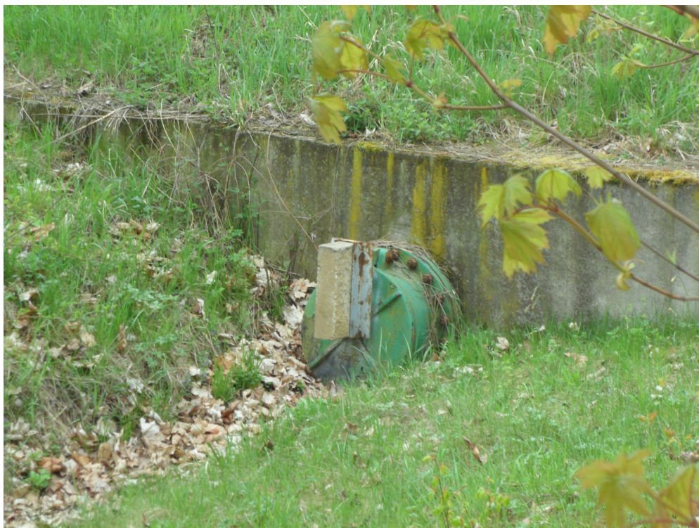
Příloha č. 15: Klapka na propustku u silnice R35 u obce Mladeč
