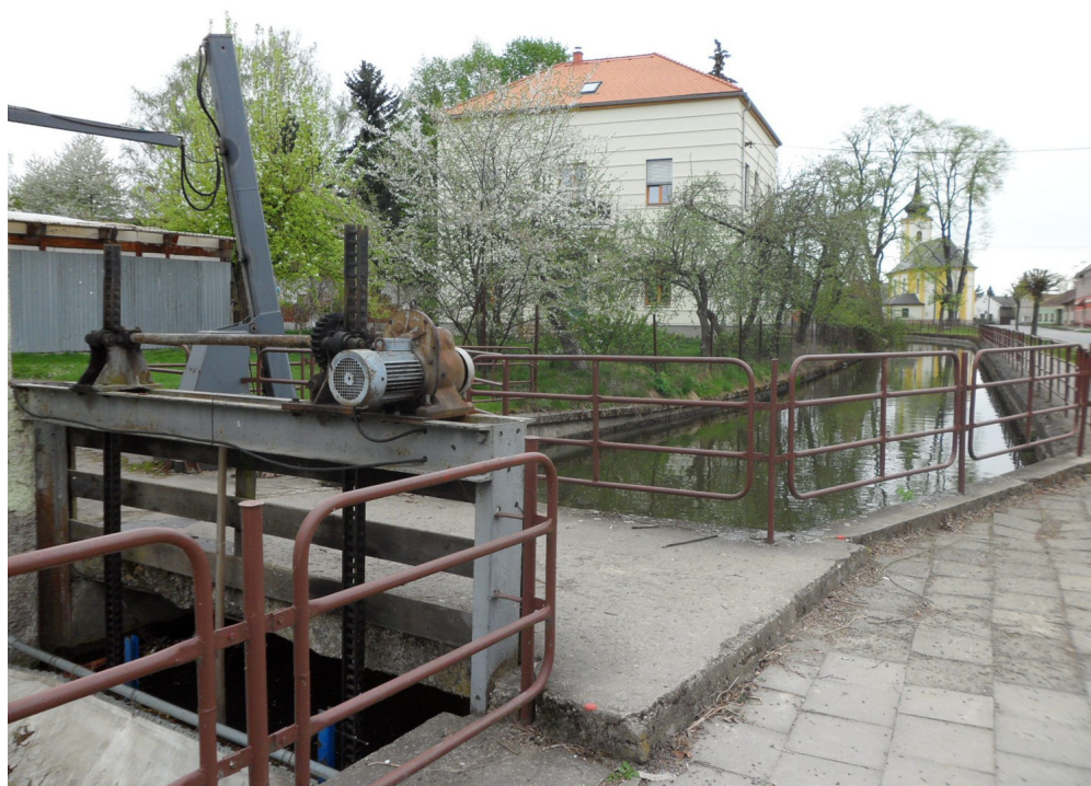
Příloha č. 10: Stavidlo vodní elektrárny na toku Oskava v obci Pňovice
