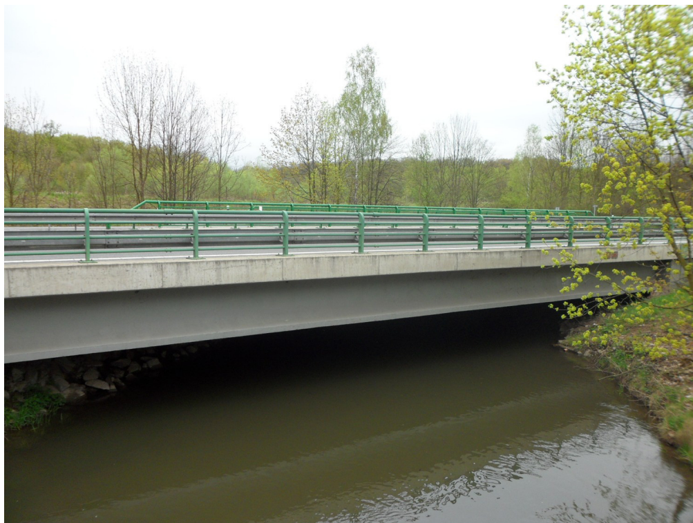
Příloha č. 14: Most přes Malou Vodu – silnice R35 u obce Mladeč
