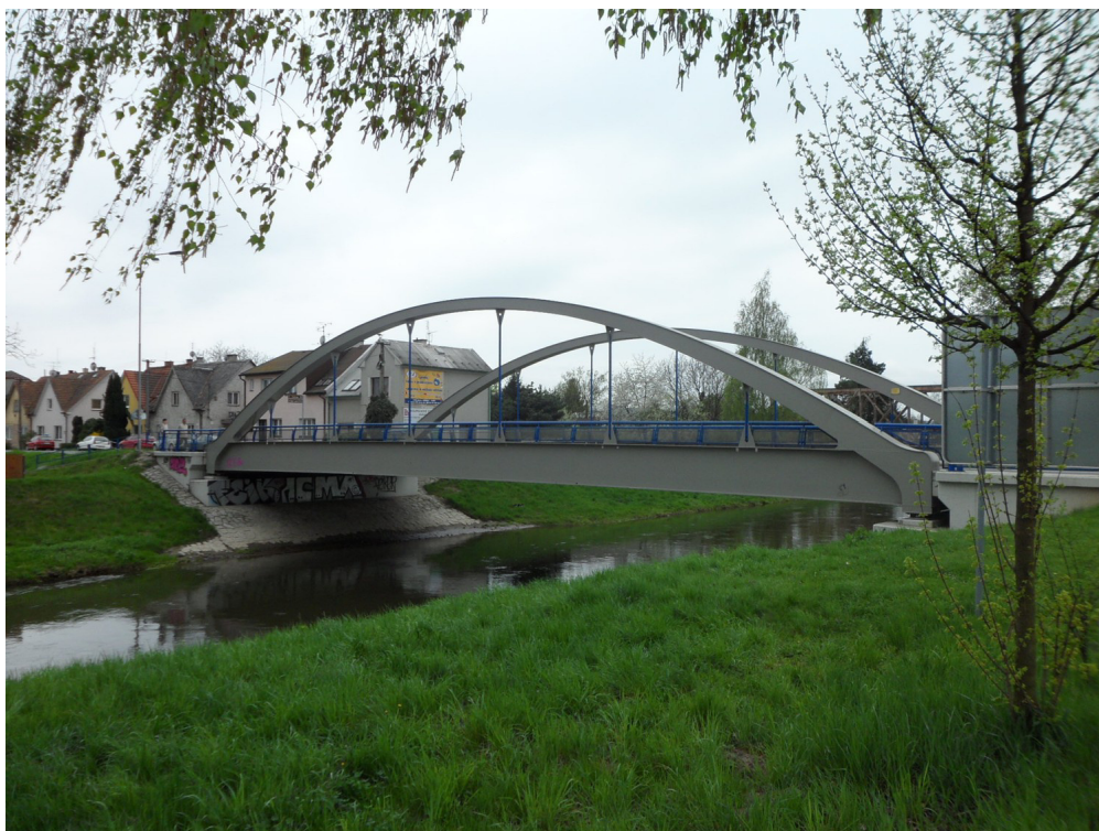
Příloha č. 22: Rekonstruovaný most přes řeku Moravu v Litovli, ulice Dukelská
