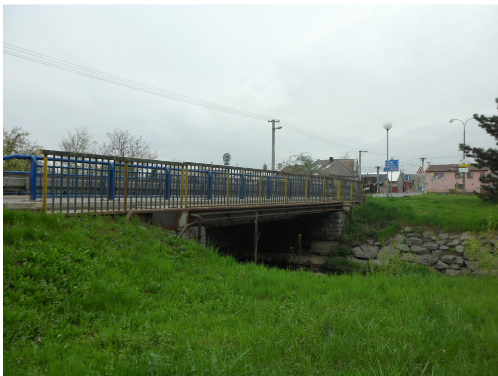
Příloha č. 12: Most a zpevněné koryto toku Čerlinky v obci Červenka
