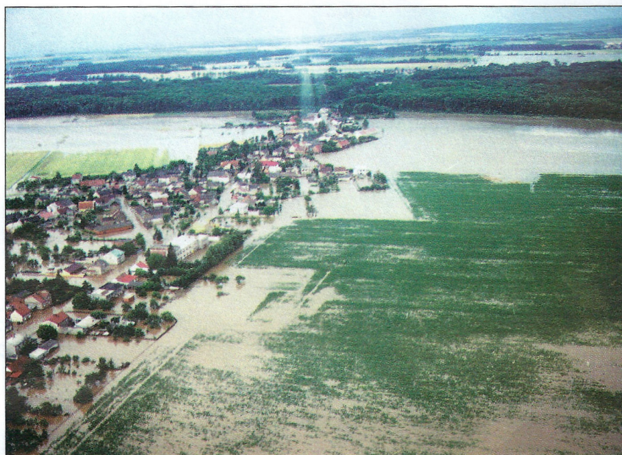
Pohled na zatopenou Střeň a kukuřičné pole 9.7. 1997
