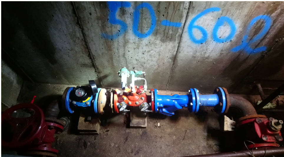
Obr. 10 Vodoměrná šachta spotřebiště Vsetín, TP 99 regulátor Sychrov DTP – indukční průtokoměr za redukčním ventilem, bez napojení na datalogger
