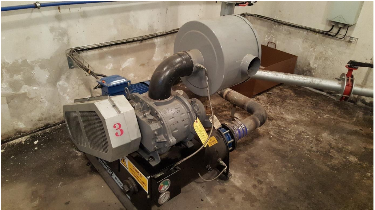
Příloha 3. Nejnovější Rootsovo dmychadlo
