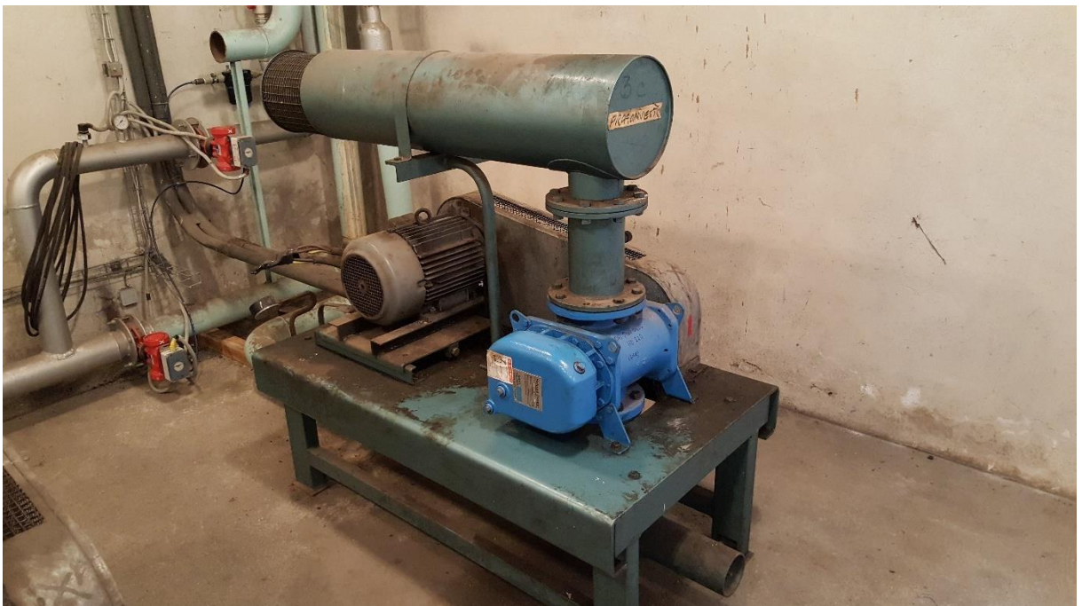
Příloha 4. Repasované Rootsovo dmychadlo
