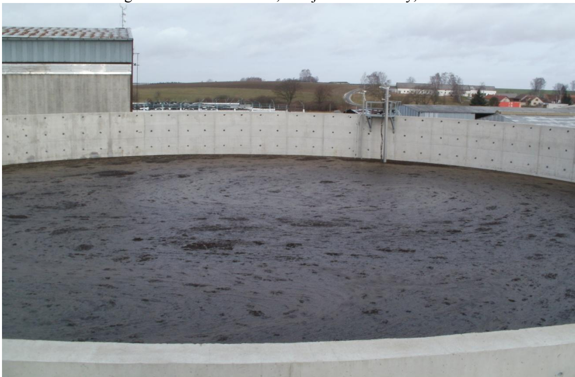
Obr.10: Jímka s digestátem v BPS Kámen, zdroj: foto Poslušný, 2013
