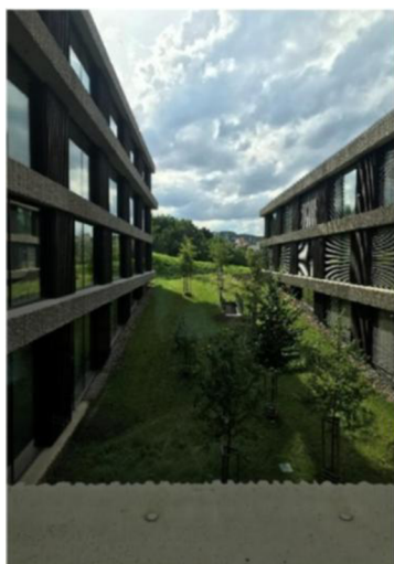
Obrázek 11: Výhled na terasu zelené střechy ČSOB v Radlicích Zdroj: vlastní
