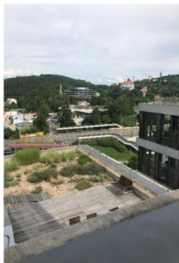
Obrázek 12: Výhled na část zelené střechy ČSOB v Radlicích Zdroj: vlastní
