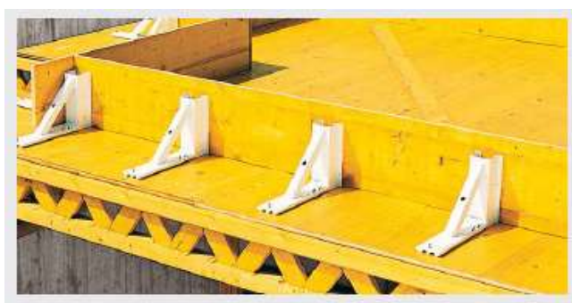
Obr. 21 – čelo stropní desky [5]
