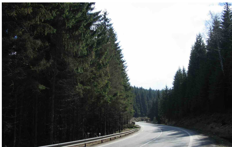
Příloha č.18: Poškozený porost u silnice I/10
