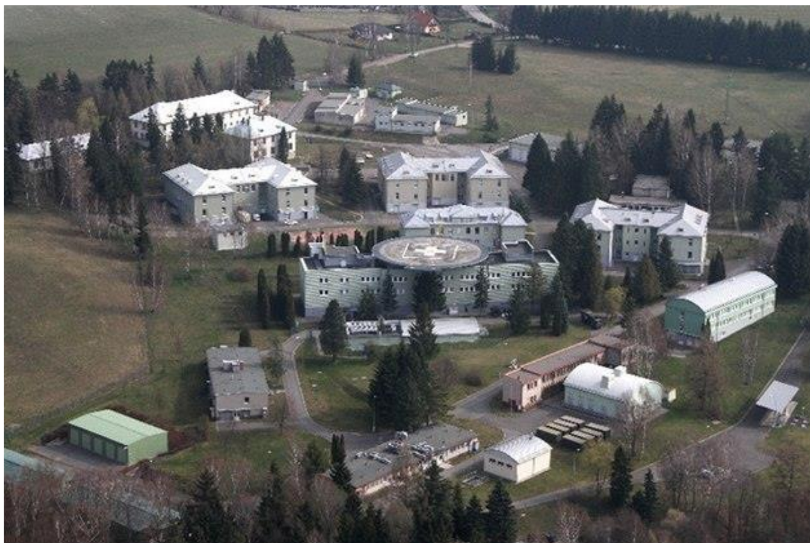
Obrázek 2: Centrum biologické ochrany Těchonín
